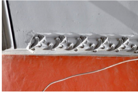
Figura 4. Moldura vertical del edificio n.ºs 46 y 48 de la avenida de Buenos Aires de Santa Cruz de Tenerife. Foto: el autor.
