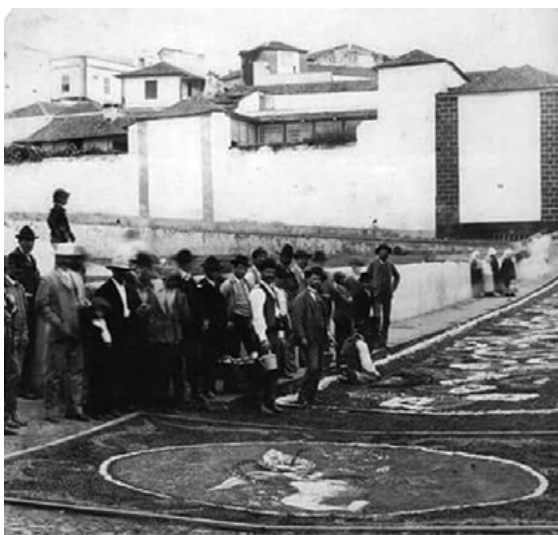
Plaza del Ayuntamiento tras la demolición del convento.
