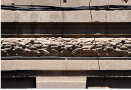
Figura 3. Moldura de laurel del edificio n.º 25 de la calle de Cruz Verde de Santa Cruz de Tenerife. Foto: el autor.
