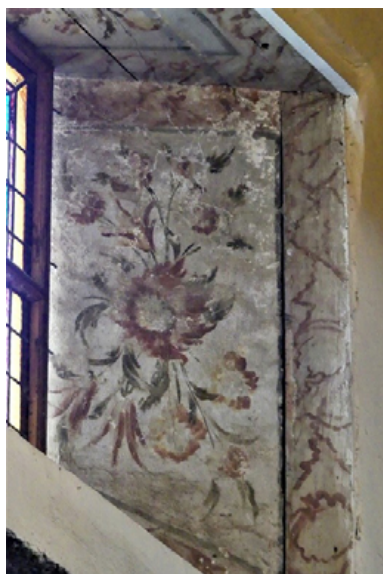
Fig. 3. Detalle de las jambas de las ventanas. Iglesia del Apóstol Santiago. Foto del autor.
