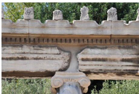
Figura 5. Banda denticular de pórtico del Ágora Romana. Atenas, Grecia. Foto: el autor.
