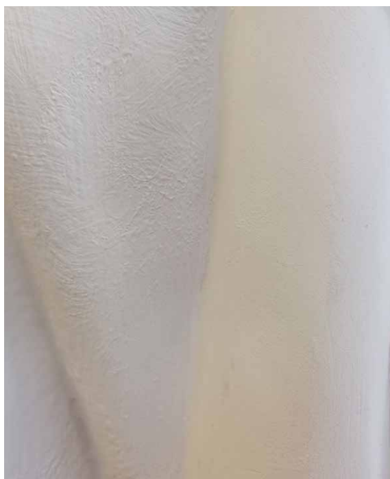
Fig.91- Detalle: aplicado de seis capas de estuco se procede al lijado. Obsérvese parte izquierda crispada y parte derecha ya lijada.
