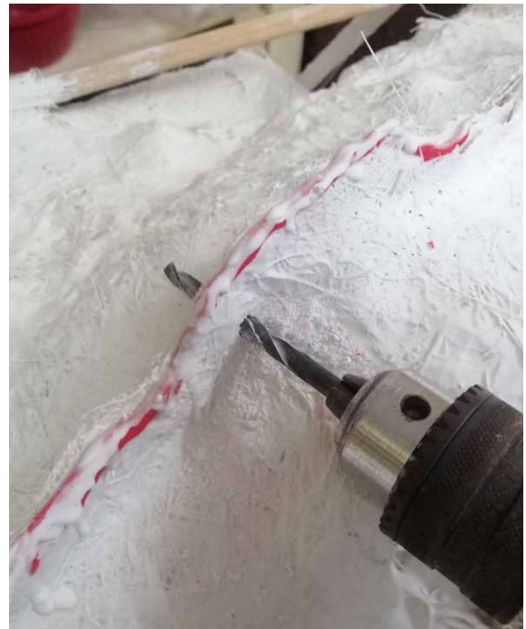
Fig.60- Apertura de los orificios para los tornillos roscados con las palometas.
