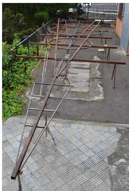
Figura 70: Estructura de hierro de uno de los arcos. Foto hecha por Elisa María Taño González.
