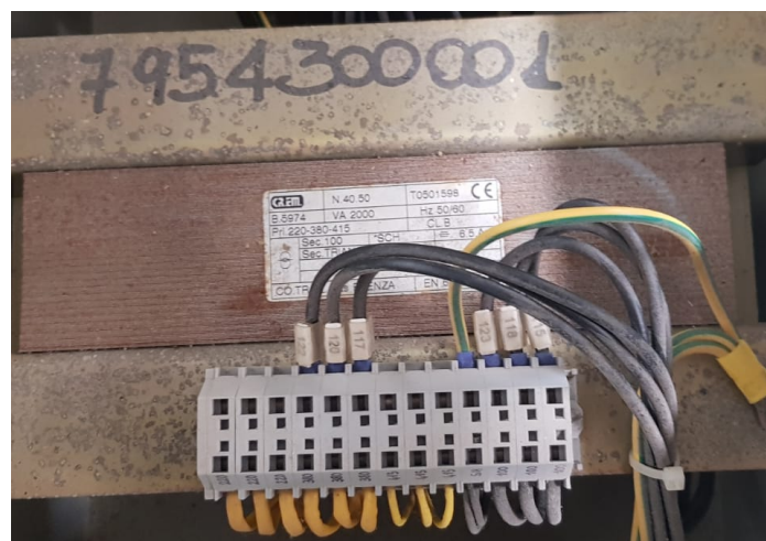
Figura 6.24: Transformador 220-380-415/100V.
