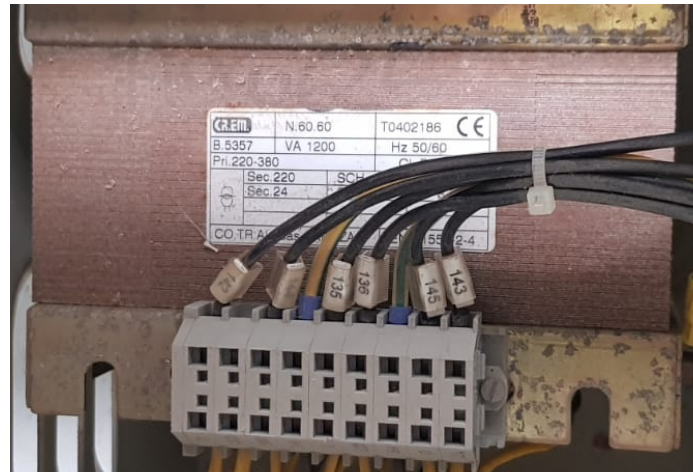
Figura 6.25: Transformador 220-380/24V.
