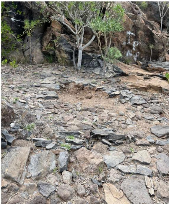
Imagen 3 Empedrado deteriorado
