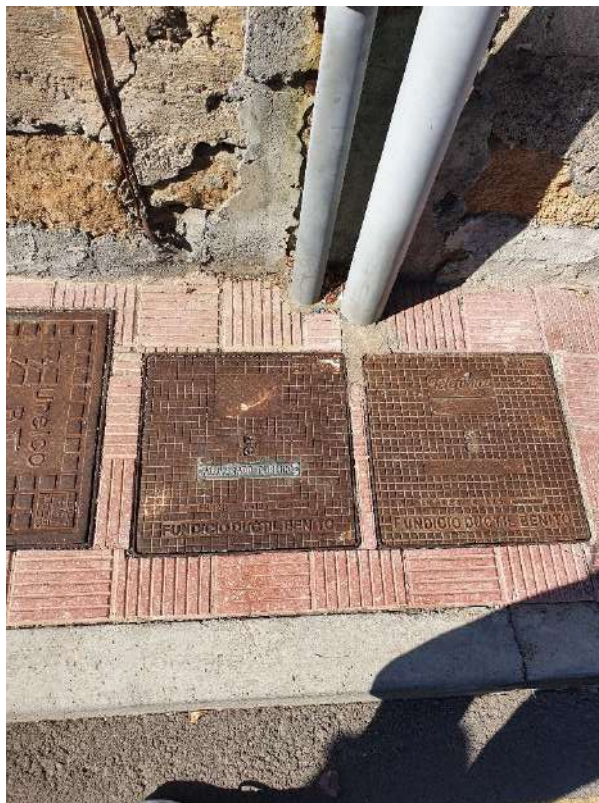
Ilustración 15. Red de abastecimiento, electricidad y telecomunicaciones existente ubicadas en aceras en todo el núcleo.
