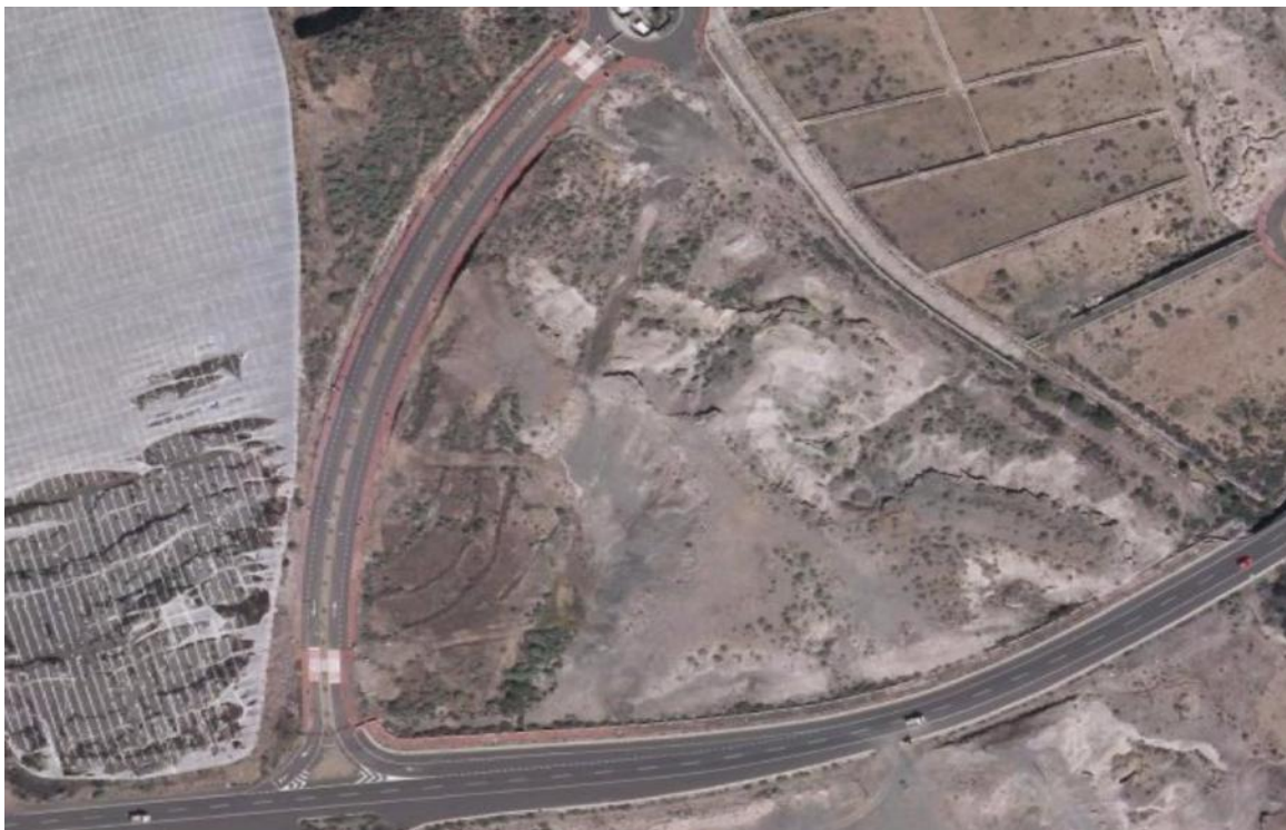
Figura 49. Parcela elegida para la ubicación de la planta desaladora.
