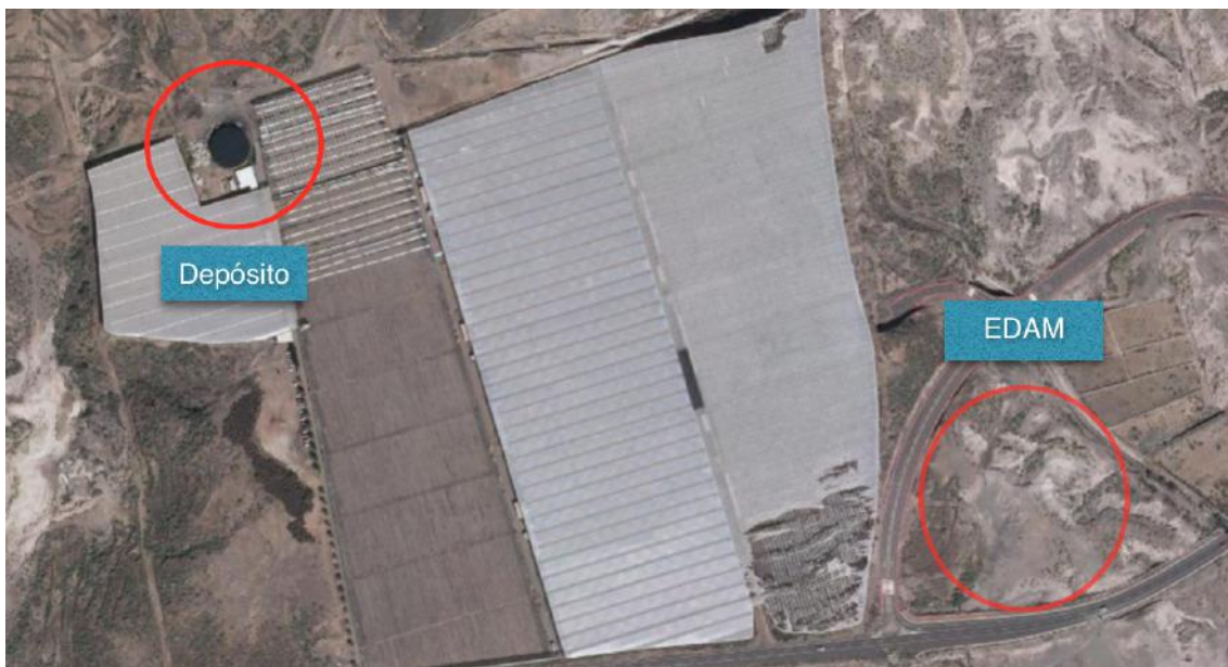
Figura 49. Situación del depósito respecto a la EDAM.
