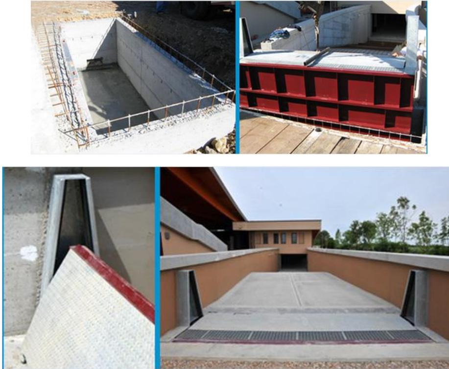
**Figura 6-3.** Montaje del sistema Ranagalle. (Ranagalle)
