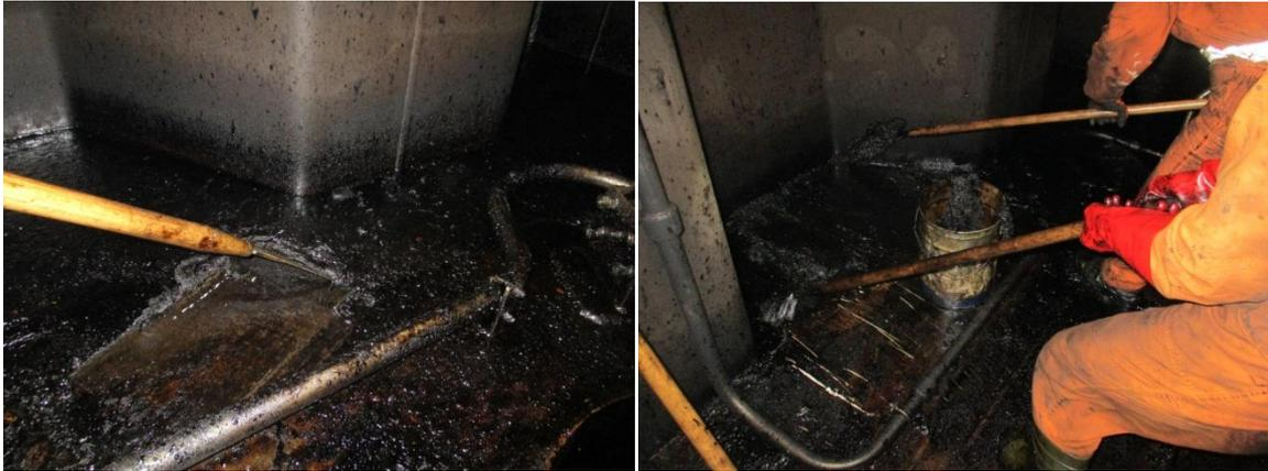
**Ilustraciones 20 y 21:** Rascado de fuel del fondo de los tanques.
