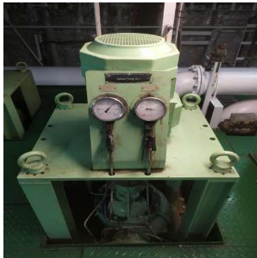
Figura 34: Bomba de lastre del buque M/V OPDR CANARIAS Fuente: [6]
