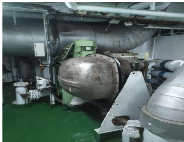
Figura 29: Generador de agua del buque M/V OPDR CANARIAS Fuente: [6]
