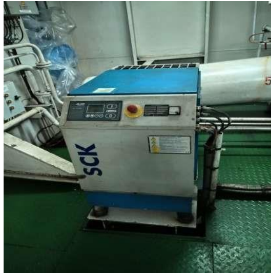
Figura 28: Sistema de aire de servicio del buque M/V OPDR CANARIAS Fuente: [6]
