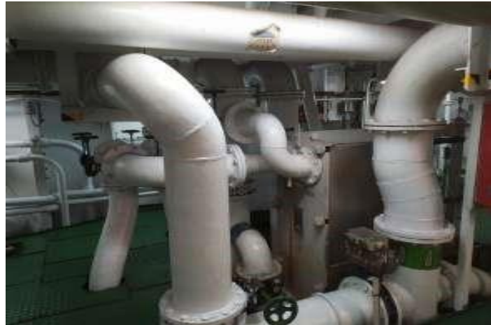
Figura 39: Enfriador de baja temperatura (LT) del buque M/V OPDR CANARIAS
