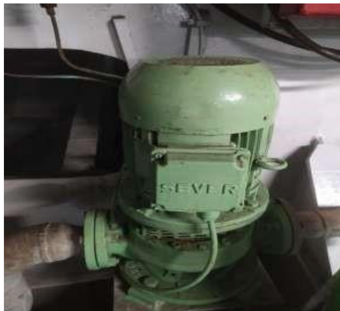
Figura 40: Bomba del evaporador del buque M/V OPDR CANARIAS
