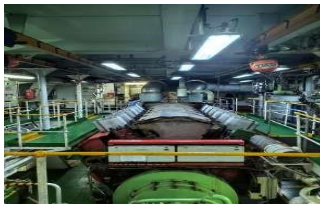
Figura 42: Motor principal del buque M/V OPDR CANARIAS Fuente: [6]
