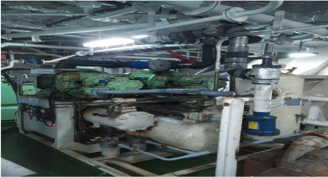
Figura 12: Compresores de aire acondicionado del buque M/V OPDR CANARIAS Fuente: [6]
