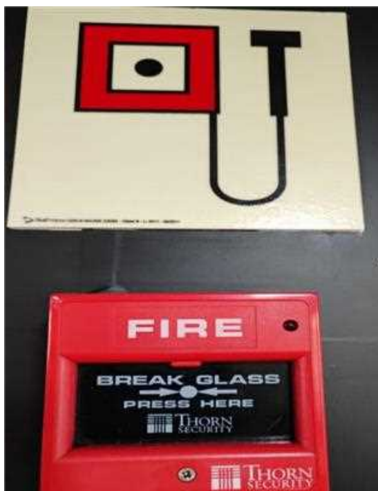
Ilustración 37: Pulsador de alarma del Volcán de Timanfaya con su señalética IMO.
