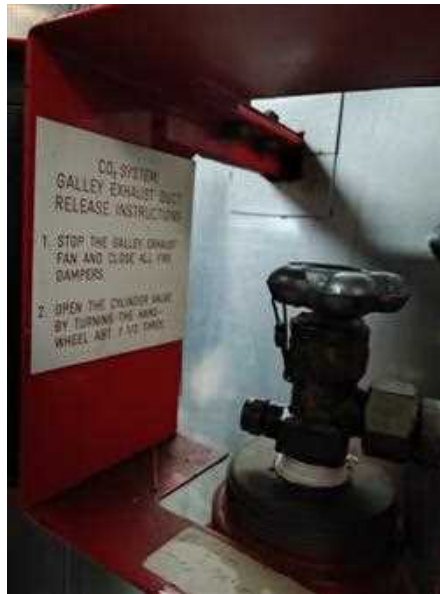
Ilustración 33: Instrucciones a seguir para un correcto disparo del CO 2 de la cocina.
