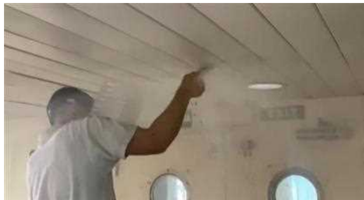
Ilustración 44: Rotura de ampolla de un “sprinkler” de acuerdo a lo prescrito en el MSC.1/1432 Capítulo 7.
