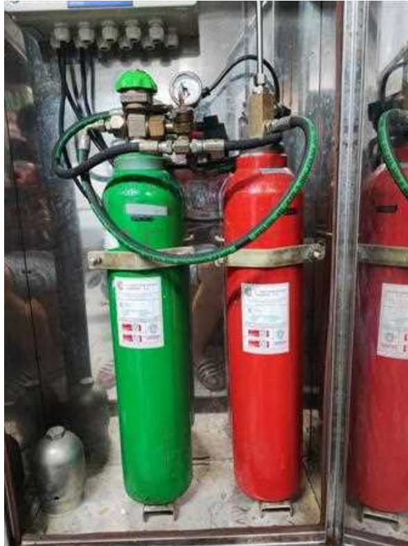
Ilustración 16: Sistema de agua nebulizada en cocina del Volcán de Timanfaya.
