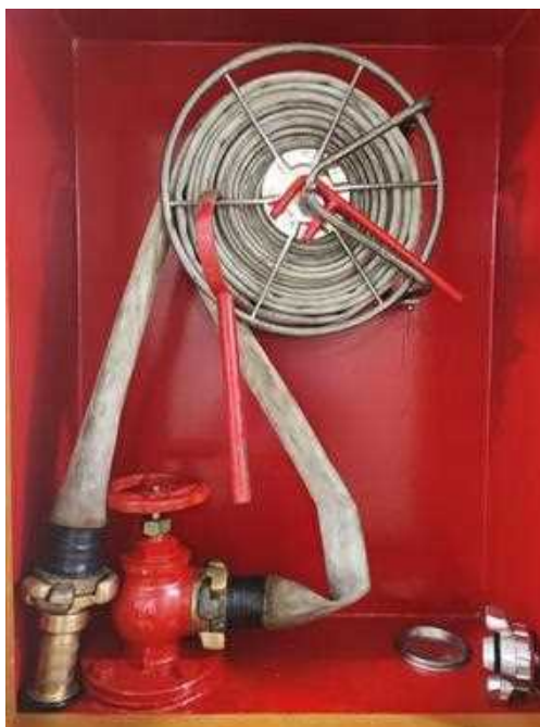
Ilustración 7: Caja de lucha contra incendios (B.I.E) del Volcán de Timanfaya.
