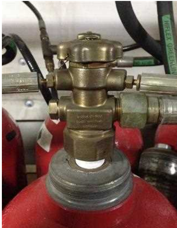
Ilustración 31: Apertura de manera manual de la botella de CO 2 .
