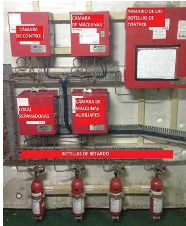
Ilustración 24: Imagen esquematizada del funcionamiento del CO 2 .
