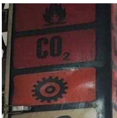
Ilustración 26: Alarma visual y auditiva de procedimiento de disparo del CO 2 .
