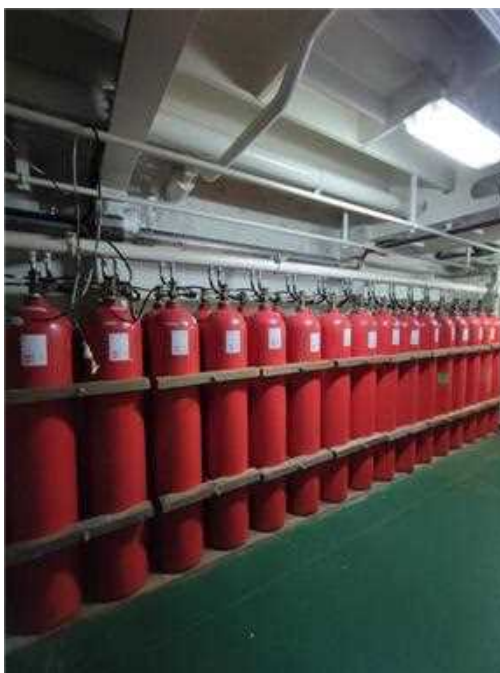
Ilustración 25: Botellas llenas de CO 2 en el local.
