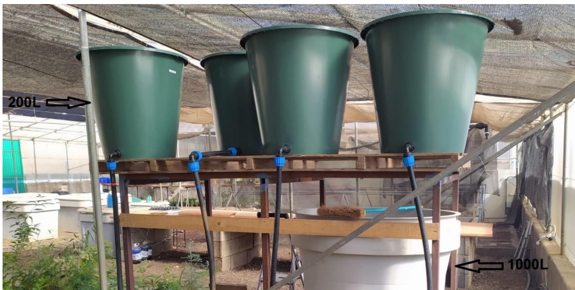
Figura 9. Instalación de bajo coste.
