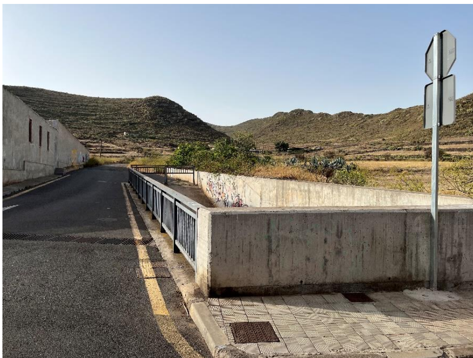
Fotografía 1. Obra de paso
