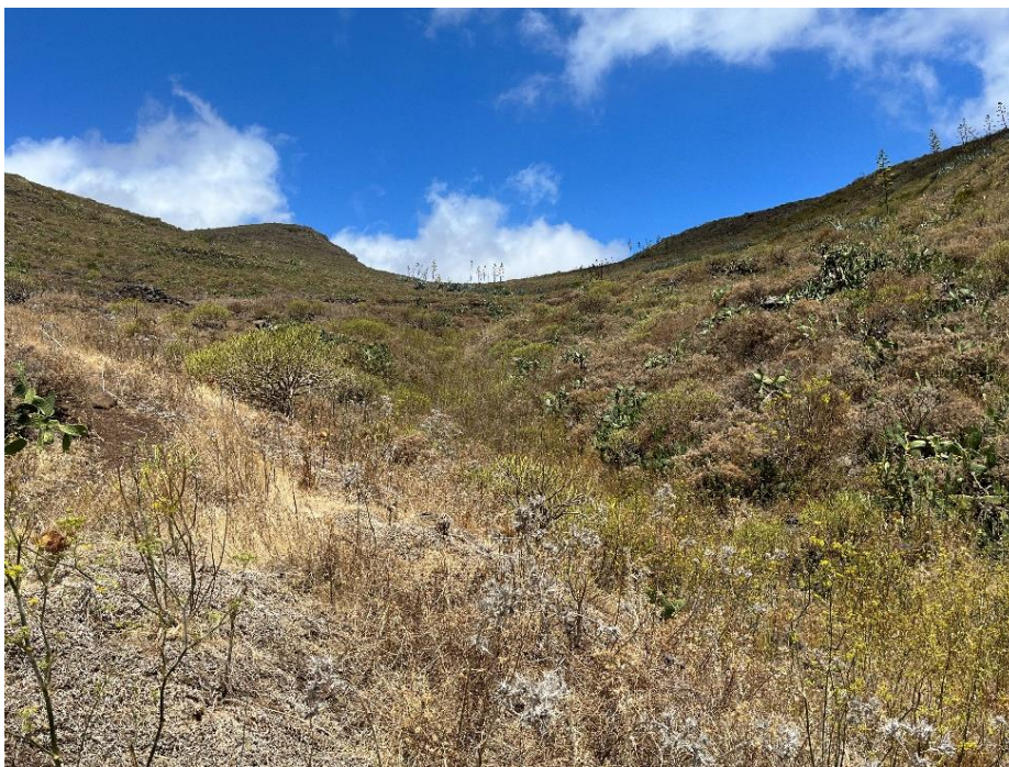
Fotografía 22. Ubicación cuneta vegetada
