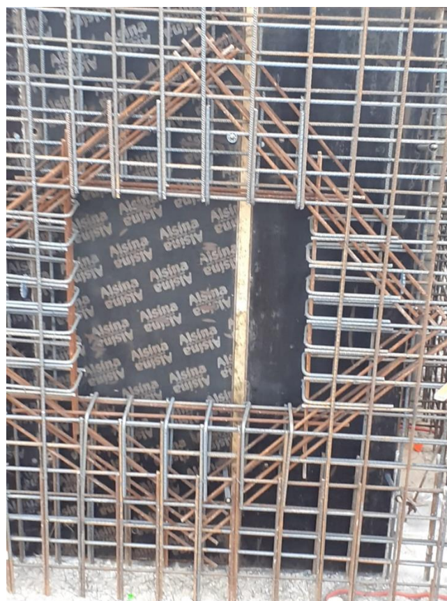
Ilustración 1. Ejemplo de la armadura en los huecos
