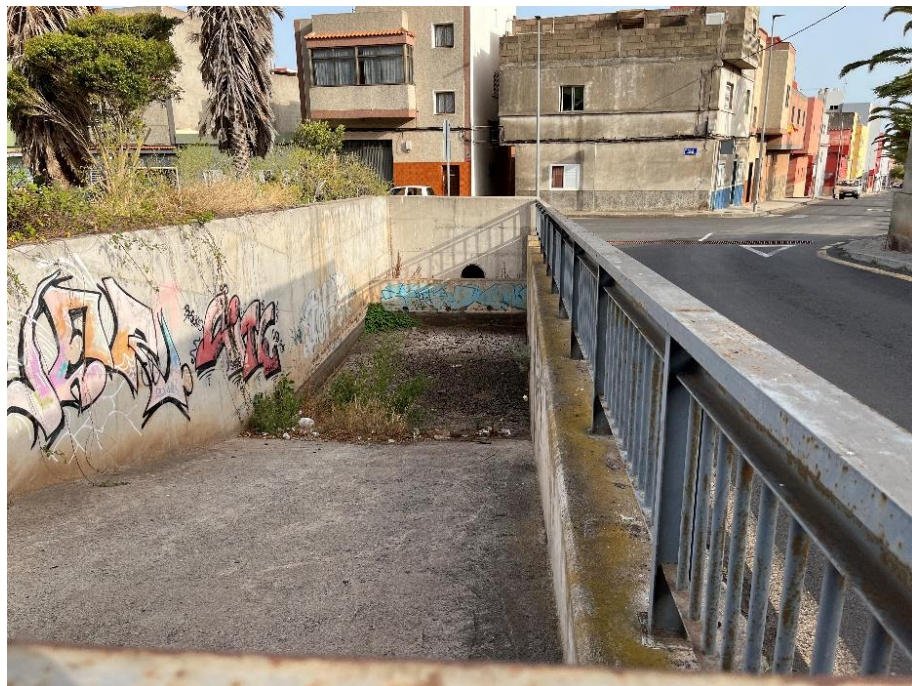
Fotografía 3. Canal de la ODT
