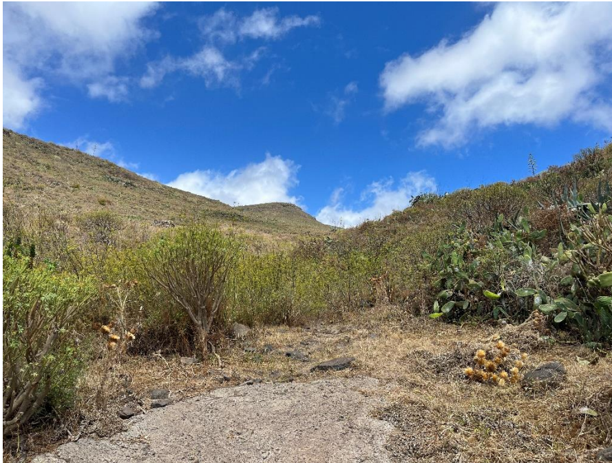
Fotografía 21. Zona cuneta vegetada
