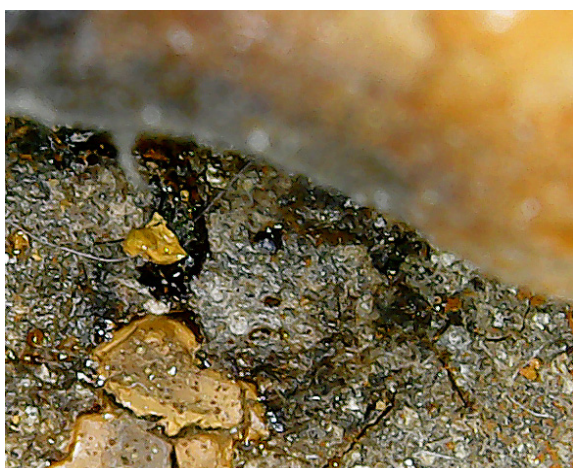
Fig.10.13. Borde de uno de los tensores con desgaste y resto de resina.
