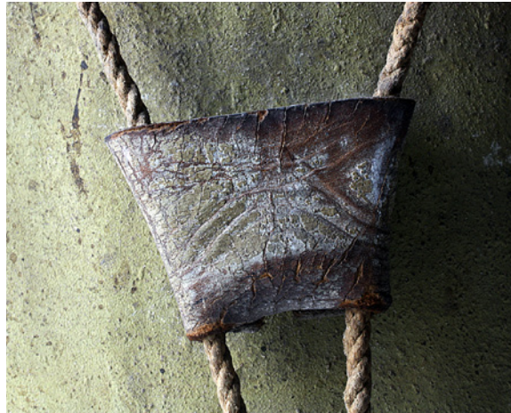
Fig.10.6. Detalle con luz rasante, tensor deteriorado.
