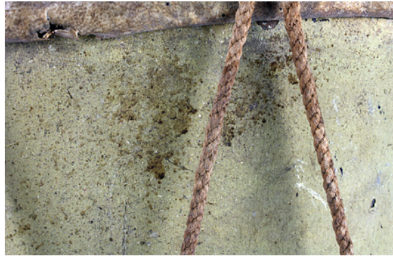
Fig.12.8. Manchas y faltas de capa pictórica.
