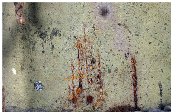
Fig. 12.6. Manchas, faltas de capa pictórica y oxidación.
