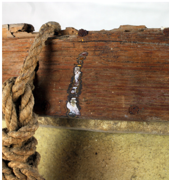
Fig. 12.2. Falta de soporte, oxidación en clavos y manchas.
