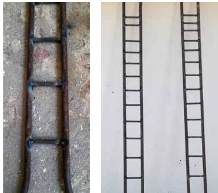
Fig. 216 ; 217 Soldadura de peldaños y elaboración de escaleras
