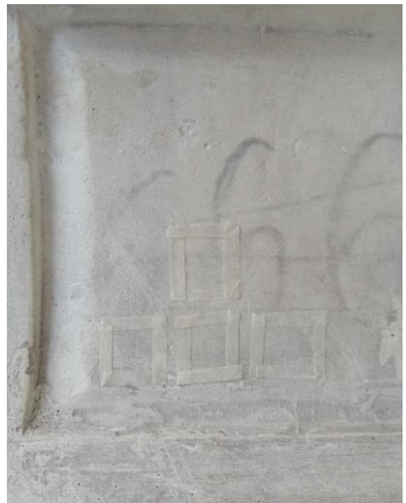
Fig. 40 Catas de limpieza en el macho cabrío
