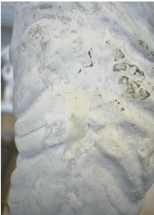
Fig. 39 restos de depósitos superficiales y retirada con empaques de algodón
