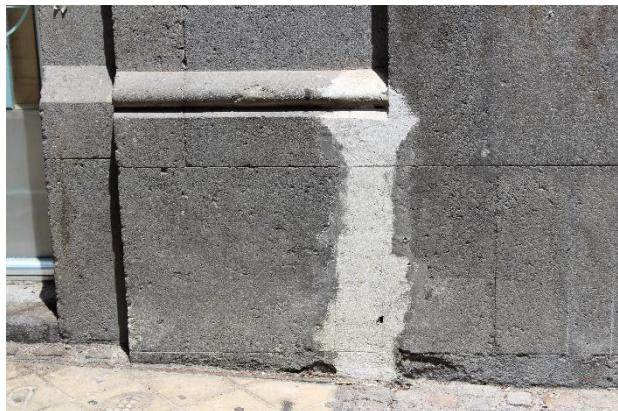
Figura 92. Intervención anterior en material pétreo.
