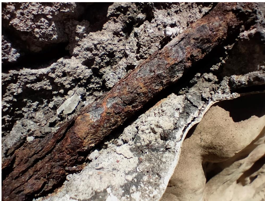
Figura 151. Macrofotografía de carbonatación, ficha 3.
