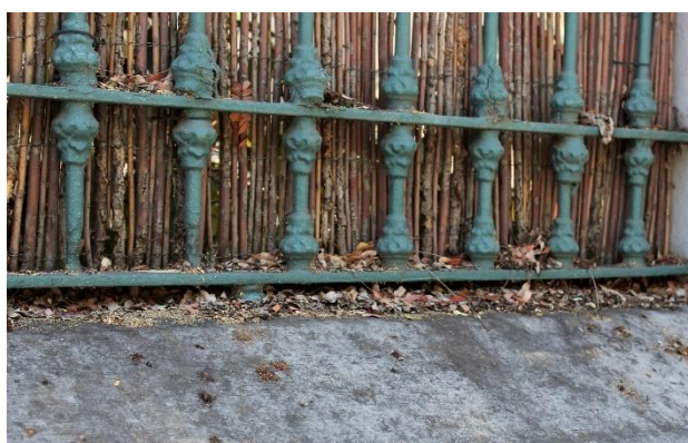
Figura 59. Deposición de elementos arbóreos excesivo.
