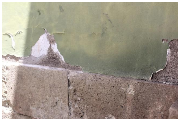
Figura 87. Diferencia de tonalidades, levantamientos y craquelados.
