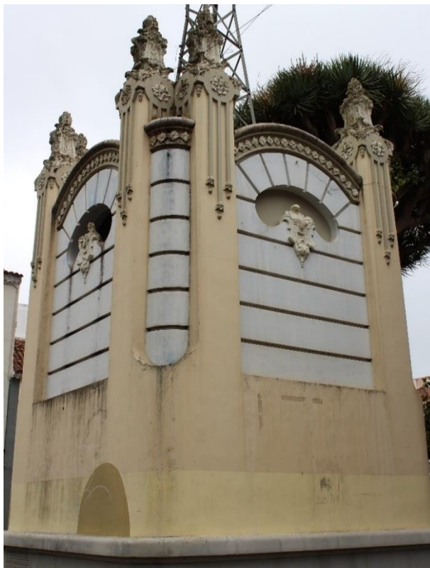
Figura 9. Transformador de energía eléctrica.
