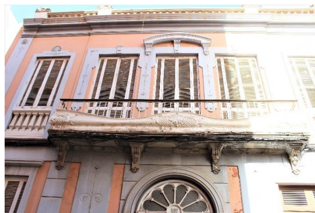
Figura 142. Peligro de desprendimiento de elementos decorativos de balconada.
