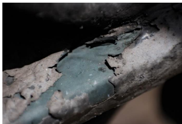
Figura 27. Macrofotografía de repinte en rejería.
