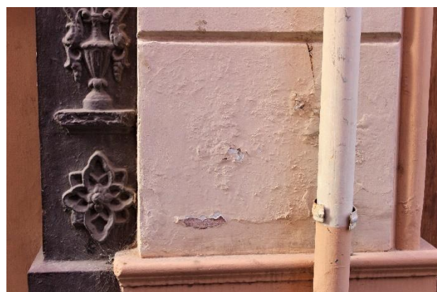
Figura 113. Diferencia de texturas y craquelados.
