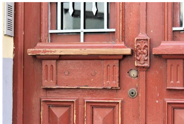
Figura 115. Desgaste en capa pictórica de puerta.
