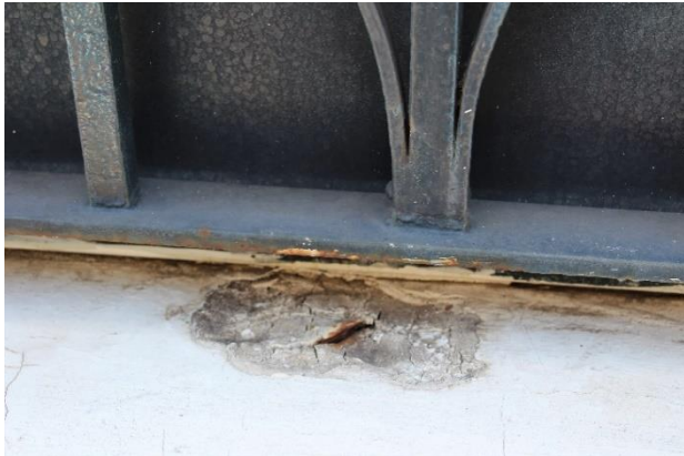
Figura 53. Pequeña carbonatación.
