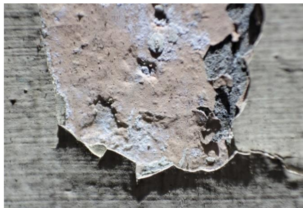
Figura 33. Macrofotografía de color original de la fachada.
