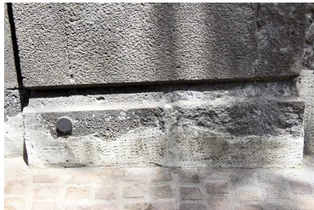
Figura 93. Intervención anterior en zócalo pétreo.
