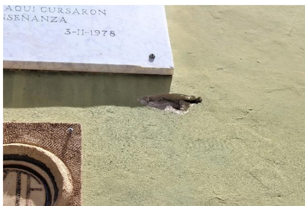
Figura 89. Falta volumétrica en frente.
