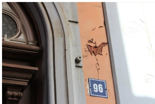
Figura 138. Craqueladuras en capa pictórica.
