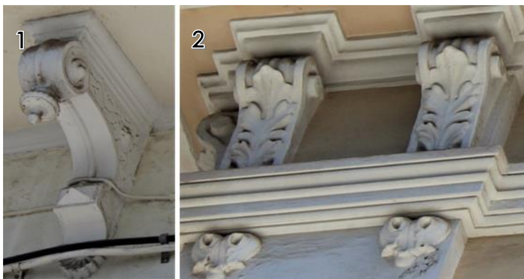
Figura 154. Ménsulas pequeñas y decorativas. Número 1, con voluta “Casa S.E.R.U.”. Número 2 con hojas de acanto, “Villa Clara”.
