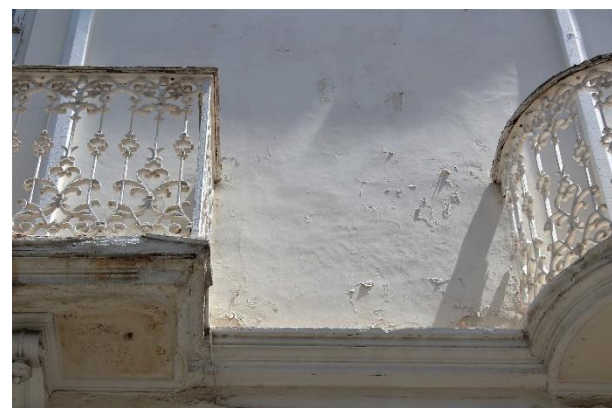
Figura 65. Craquelado y diferencia de texturas.
