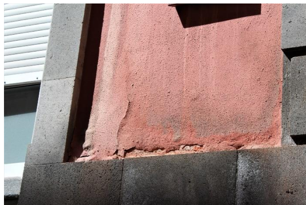
Figura 123. Abolsamiento y craquelado.
