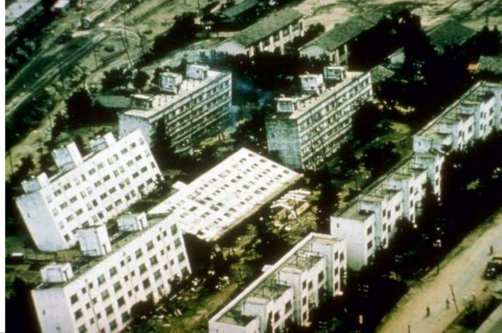
Fig.21 Licuación del suelo en Niigata, Japón. 1964 Fotografía cortesía de Wikipedia Commons
