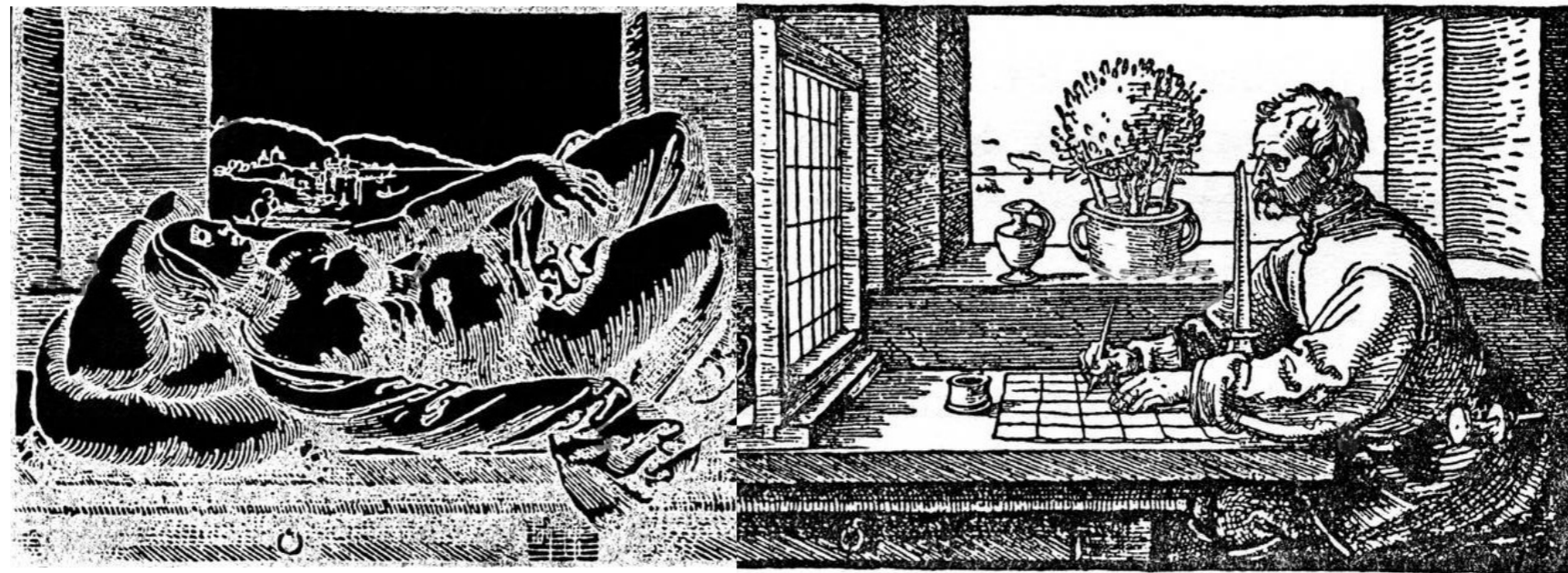
Fig. 42 y 43 Máquinas de perspectiva. A la derecha se traza la perspectiva respecto a la pared de detrás del usuario y abajo respecto a una retícula que se situa entre el usuario y el "objeto" a representar, Grabados de Alberto Durero, 1537
