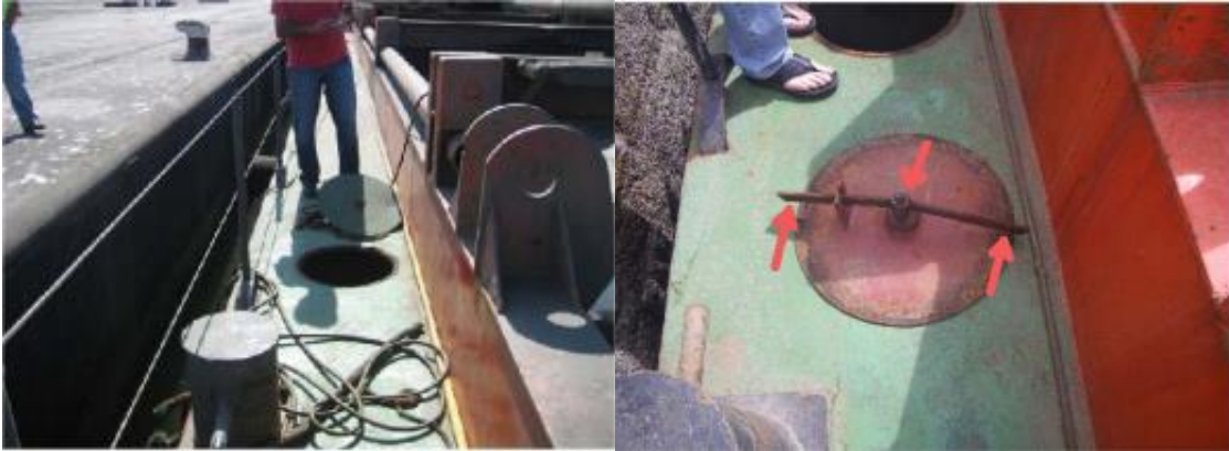
Ilustración 12. Abertura del compartimento lateral estanco 3-Br y vista de la parte inferior de la tapa y su travesaño (CIAIM, 2012).
