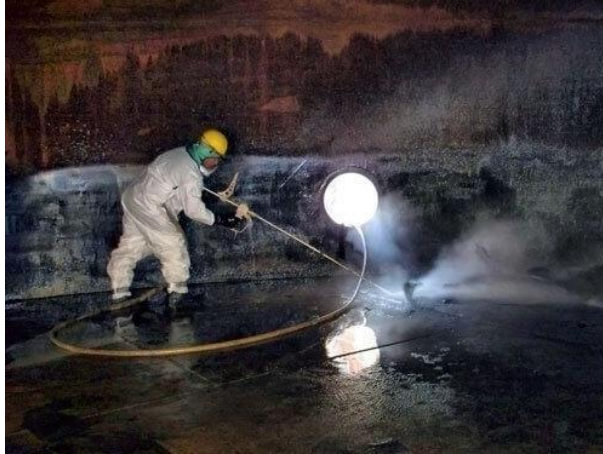
Ilustración 1. Limpieza del interior de un tanque de carga (Supportservice, s.f.).
