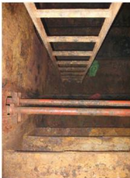
Ilustración 13. Interior del compartimento donde se produjo el accidente visto desde la abertura (CIAIM, 2012).
