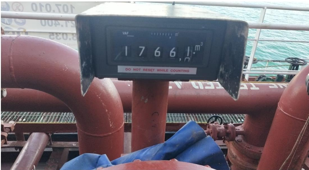
Control digitalizado de operaciones en el buque petroport
