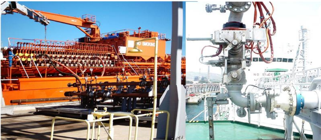
Imagen 13. Operaciones de Acople de mangueras y brazos
