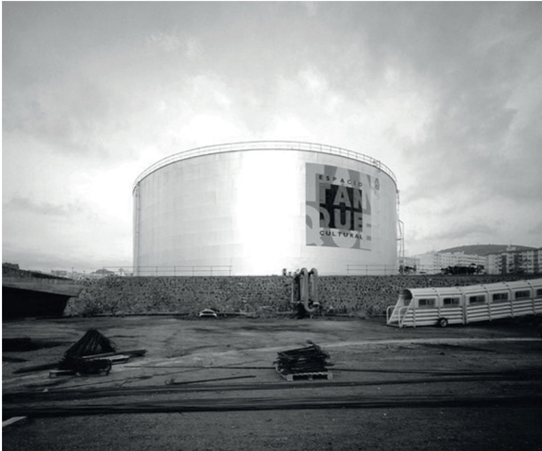
(fig. 10) Exterior de la estructura
