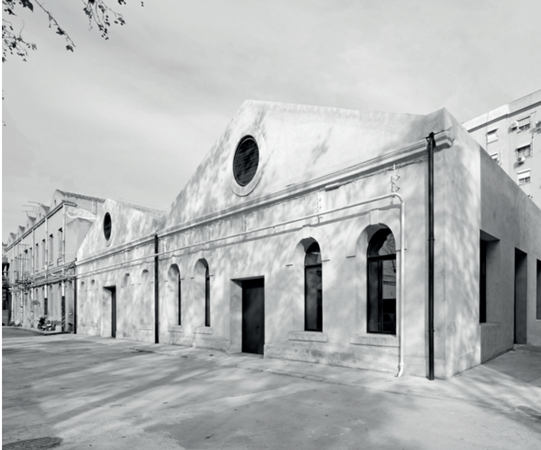
(fig. 7) Fachada de Hangar
