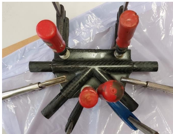
Figura 79: Pegado de la unión mediante sargentos (2)
