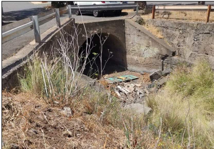
FOTOGRAFÍA Nº1: OBRA DE PASO Nº1 BARRANCO CARMONA
