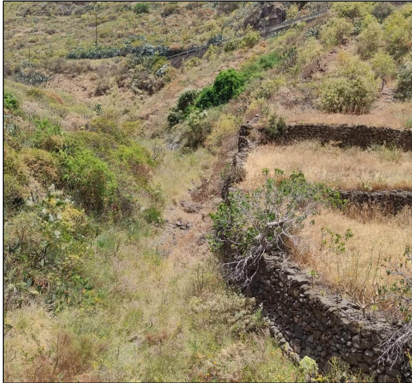
FOTOGRAFÍA N°12: TRAMO INFERIOR BARRANCO HILARIO
