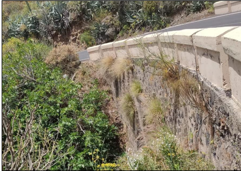
FOTOGRAFÍA Nº10: CARRETERA BARRANCO HILARIO
