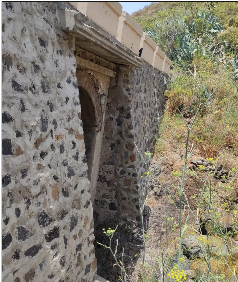
FOTOGRAFÍA N°9: OBRA DE PASO BARRANCO HILARIO
