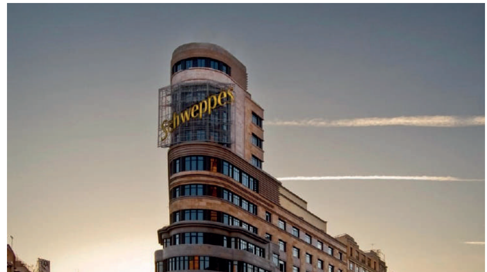
Edificio Carrión en Madrid, España.
