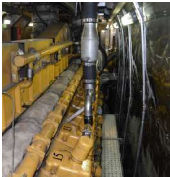
Ilustración 54. Venteos de aceite. Fuente: Trabajo de campo
