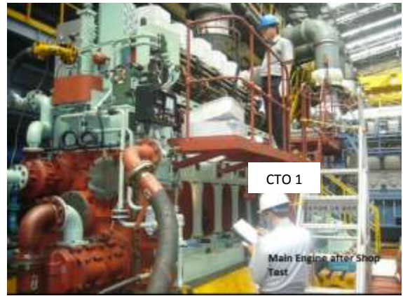
Ilustración 3. Motor principal del buque en el banco de pruebas del astillero. Fuente: Archivos fotográficos cedidos por el buque.
