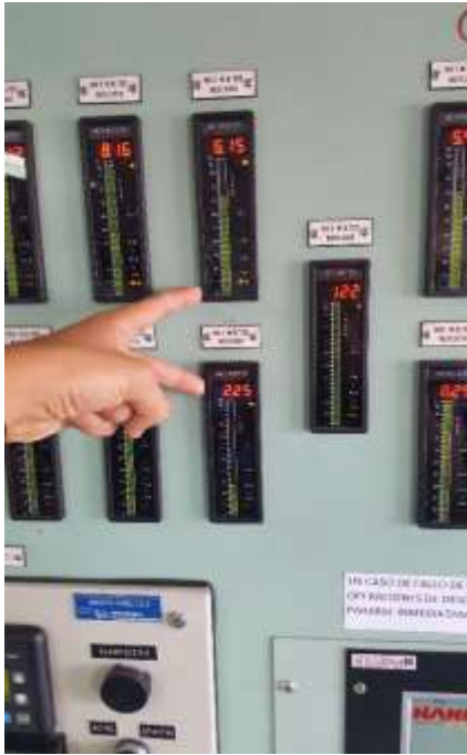
Ilustración 63. Tanque de lastre de babor con más lastre que el de estribor mientras se secan los tanques de carga de estribor. Fuente: Elaboración propia.
