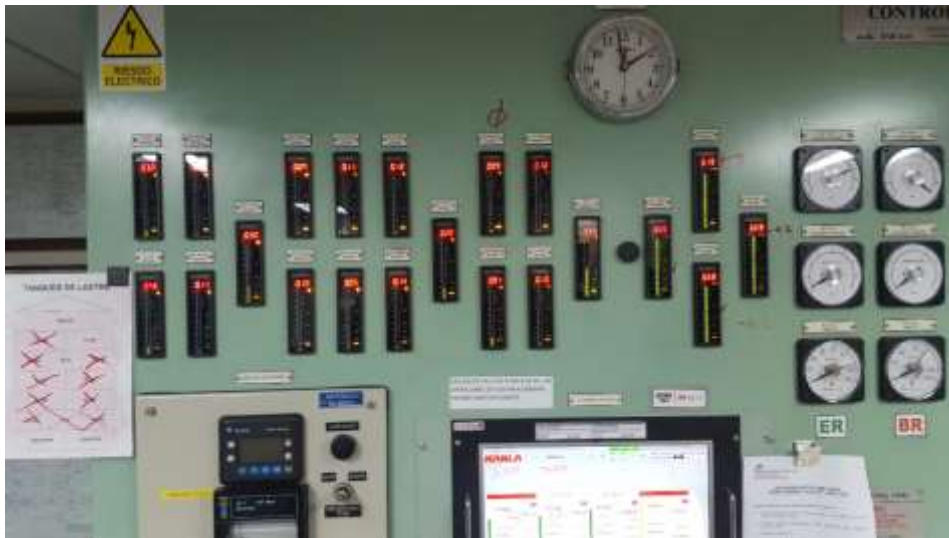
Ilustración 52. Tanques de lastre secos a excepción del Peak y el uno estribor. Fuente: Elaboración propia.
