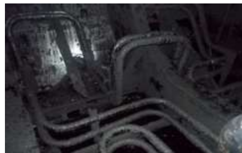
Ilustración 45. Serpentines de aceite térmico dentro de los tanques de carga. Fuente: Elaboración propia.
