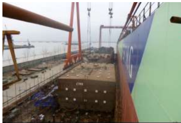
Ilustración 12. Bloque 1 de 2 de los tanques de carga. Fuente: Archivos fotográficos cedidos por el buque.
