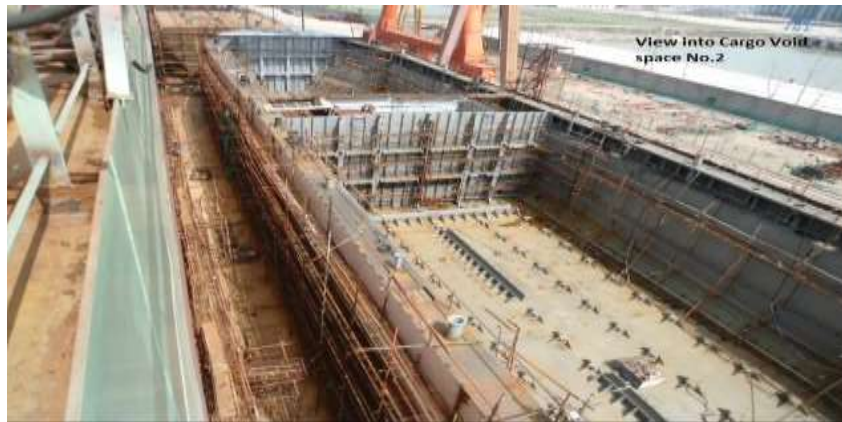
Ilustración 10. Espacios vacíos previo a la instalación de los tanques de carga. Fuente: Archivos fotográficos cedidos por el buque.
