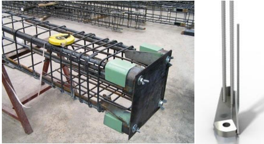
Fig 36: Colocación cimentación de pilar. Fuente: Peikko
