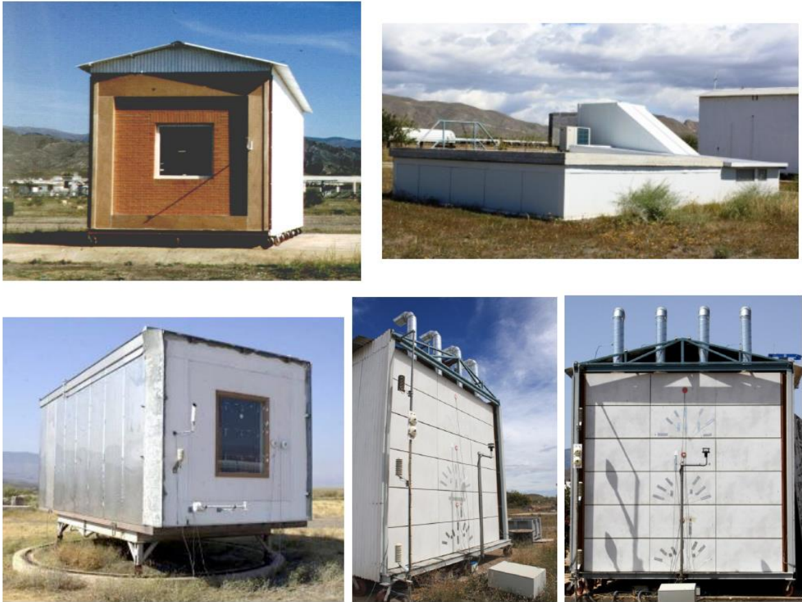
Fig 4: Laboratorio de ensayos energéticos para componentes de la edificación. Fuente: PCA (LECE)
