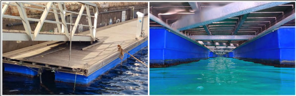
**Figura 2.** Modelo típico de pantalán flotante con disposición de los flotadores de aspecto de “catamarán”. Visto desde el exterior e interior.
