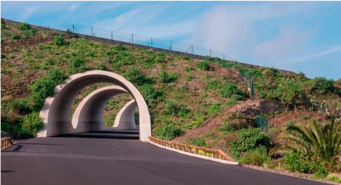
**Figura 2.** Falsos túneles en el tramo de carretera comprendido entre El Tanque e Icod de los Vinos. Recuperado de <https://blog.ferrovial.com/es/2014/11/construccion-y-proteccion-del-entorno-natural-de-la-mano-en-canarias/>
