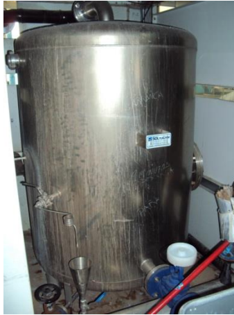
Figura XII. Depósito de condensado vertical
