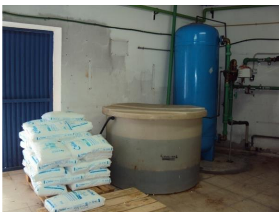
Figura VI. Descalcificador primario
