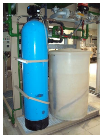
Figura VII. Descalcificador secundario
