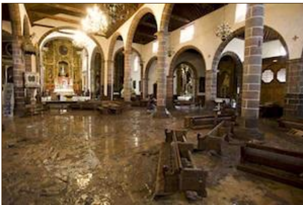
Imagen 6: Interior del templo tras la inundación de febrero de 2010.
