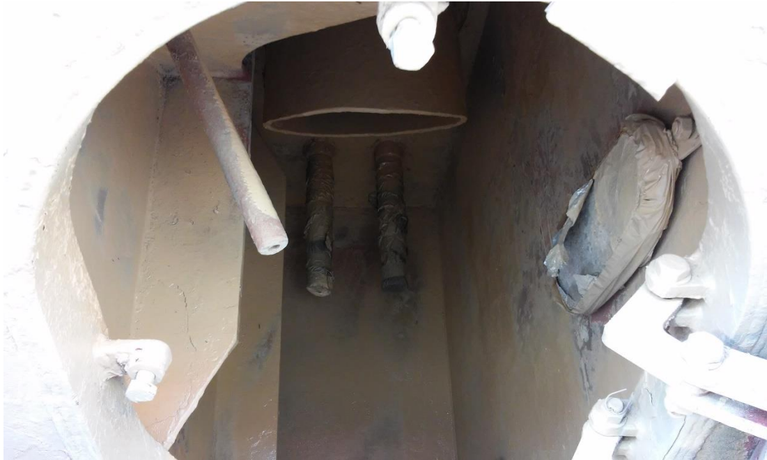
Imagen 8: Ánodo instalado en el interior de toma de agua de mar. B/F “Volcán de taburiente”. Fuente propia.
