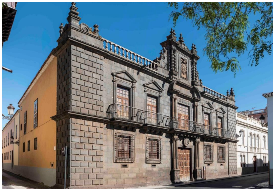
Figure 8 Casa de Nava y Grimón, fachada principal Ayuntamiento de La Laguna
