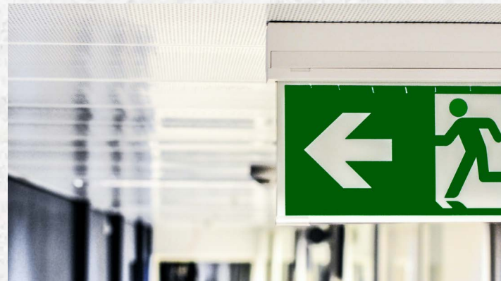
Figura 8. Señal de salida de emergencia.
