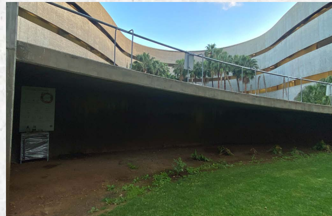
Figura 90. Interior de la facultad zona derecha de semilleros.
