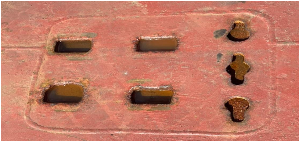
Ilustración 37: Punto de anclaje. Fuente: Elaboración propia.
