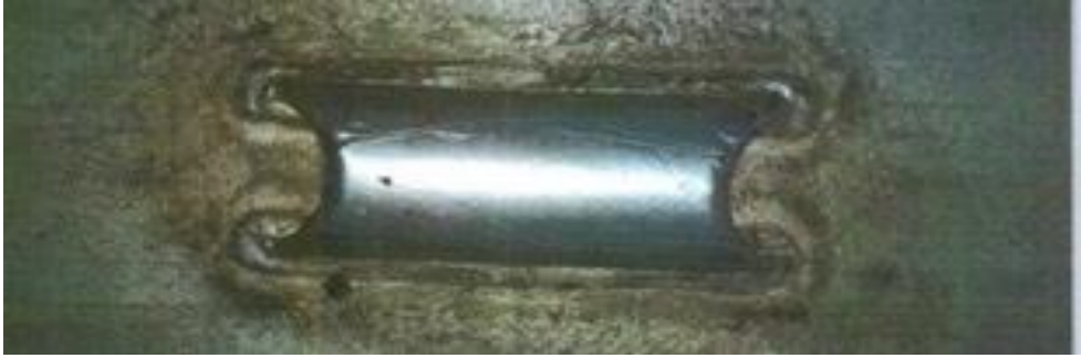
Ilustración 85: Canal de amarre de media caña. Fuente: Elaboración propia.
