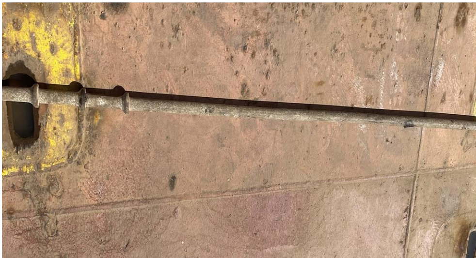
Ilustración 59: Barra de contenedores. Fuente: Elaboración propia.
