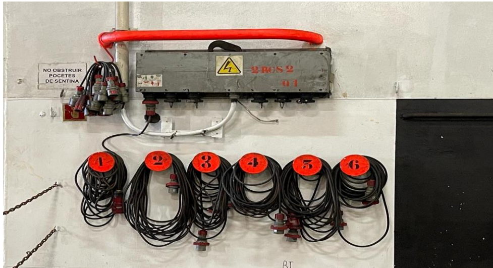
Ilustración 15: Cuadro de enchufes para los reefers. Fuente: Elaboración propia.
