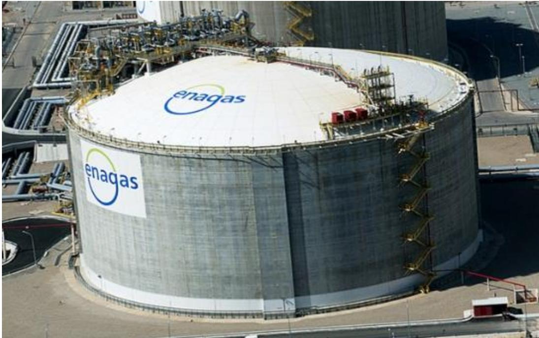
**Figura 4.** Tanque criogénico para almacenamiento de gas natural [8].
