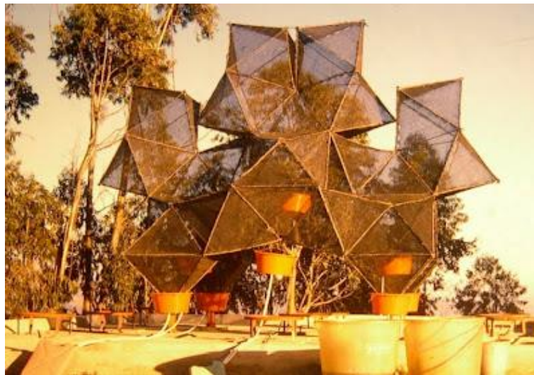
Figura 8. Captador de agua de niebla tridimensional macrodiamante, diseñado por Carlos Espinosa en 1958 (Chile). Fuente: Libro Agua de Niebla (2014).
