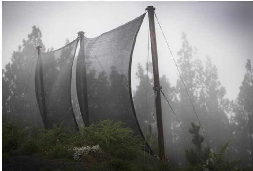
Figura 11. Captador de agua de niebla bidimensional o tipo chileno. Fuente: portalfruticola.com
