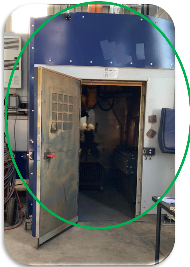
Ilustración n°21: Celda de corte Fuente: Trabajo de campo.
