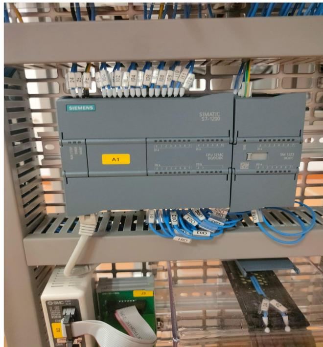
*Figura 30: Autómata de la estación FAS-216 con su módulo de expansión*
