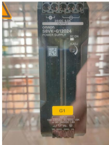
Figura 29: Fuente alimentación de la estación FAS-216
