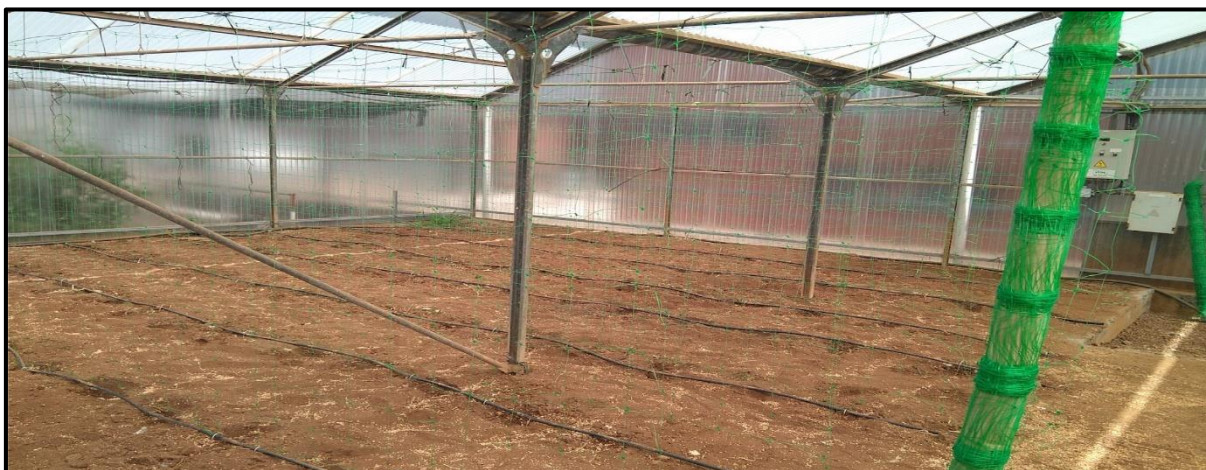
Foto 12: Colocación de las mallas de entutorado.
