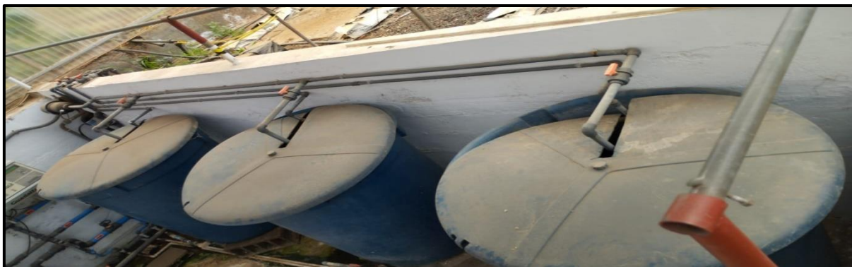
Foto 6: Tanques de abonado.
