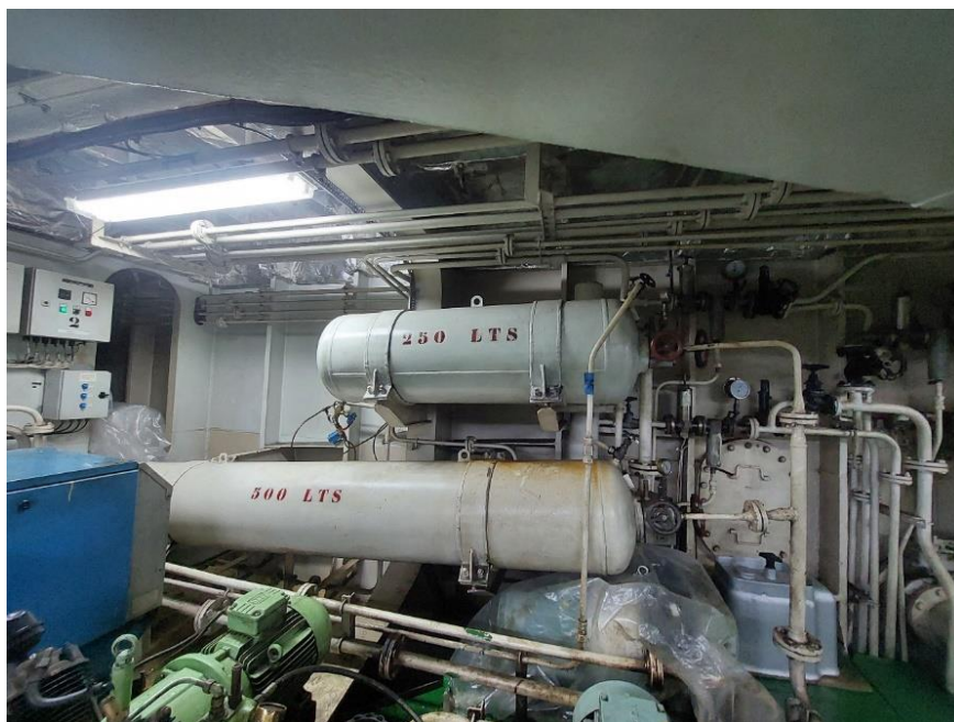
Ilustración 174. Botellas de aire comprimido. Elaboración propia.
