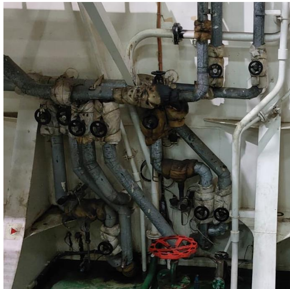
Ilustración 100. Piano de válvulas de aceite térmico de tanques de almacén. Elaboración propia.
