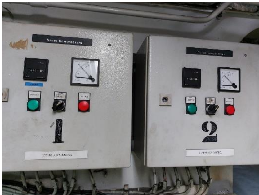
Ilustración 172. Cuadro para cambio de prioridades de los compresores. Elaboración propia.
