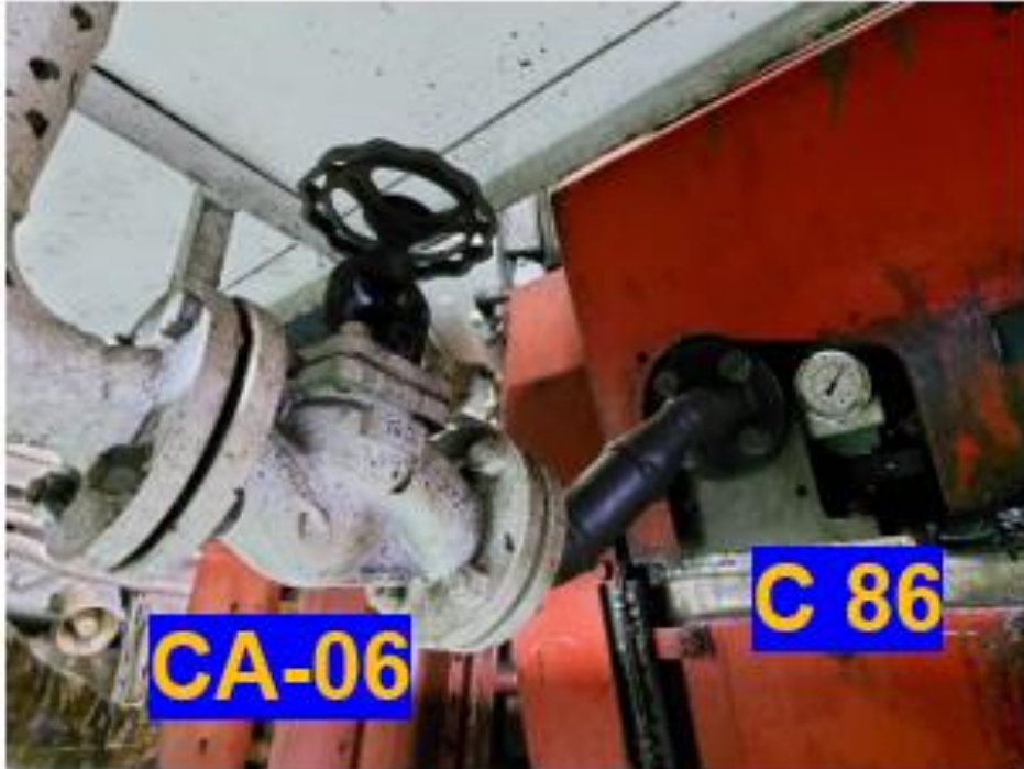
Ilustración 178. Muestra de válvulas a la entrada del motor. Elaboración propia.
