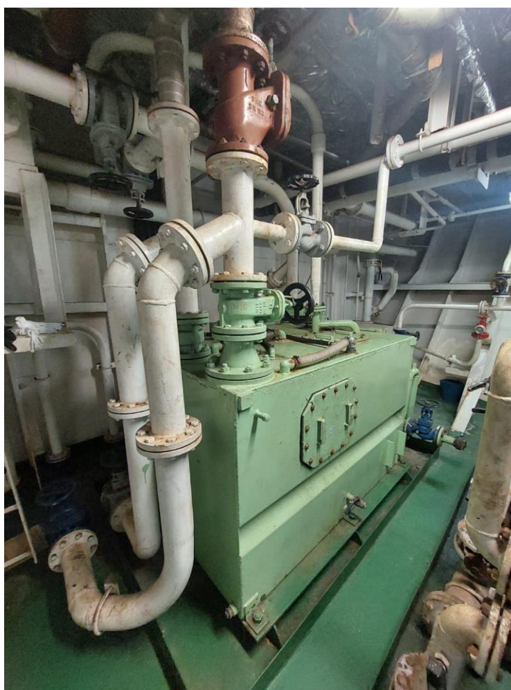
Ilustración 61. Planta séptica. Elaboración propia.
