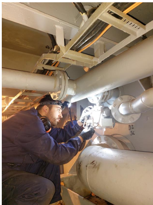
Ilustración 71. Desmontaje de actuador neumático para mantenimiento. Elaboración propia.
