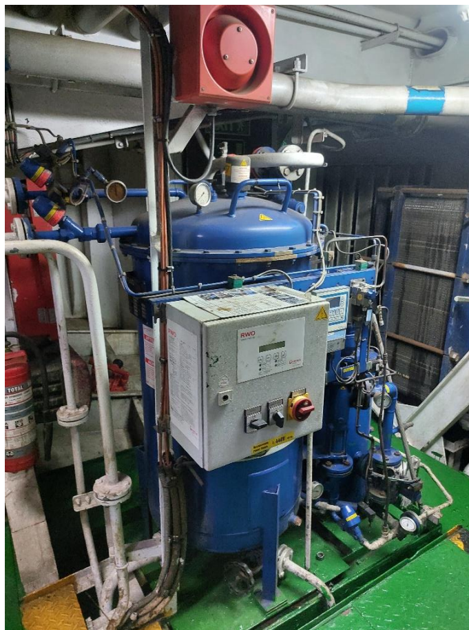
Ilustración 36. Separador de sentina. Elaboración propia.
