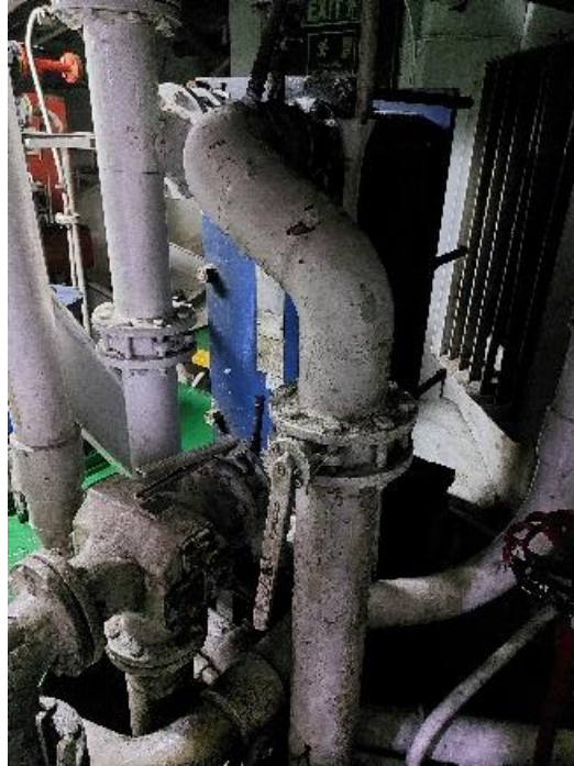
Ilustración 143. Termostática de aceite. Elaboración propia.
