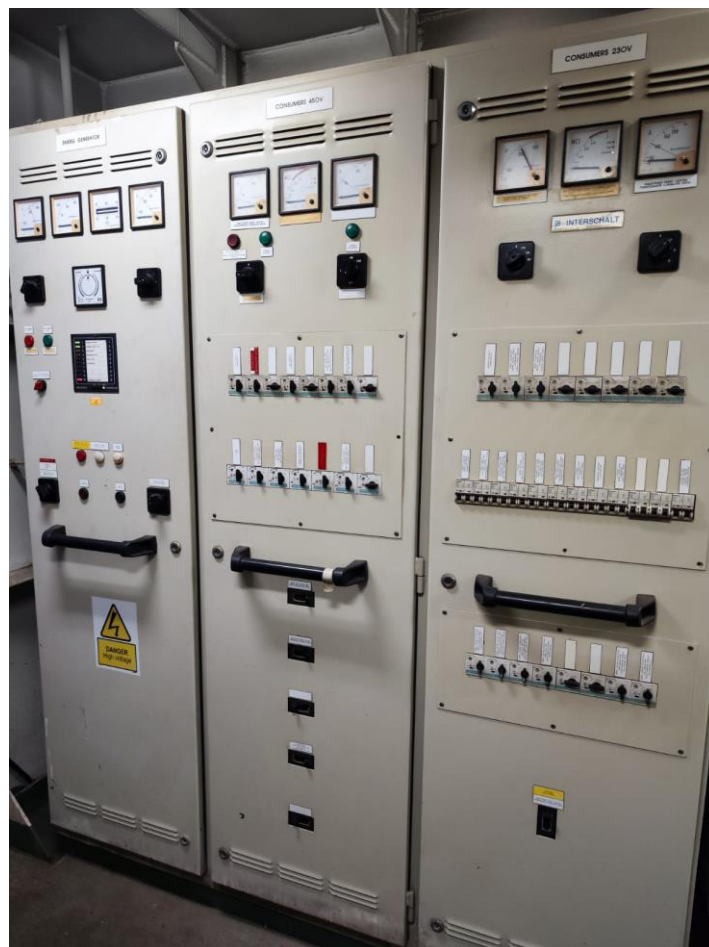
Ilustración 43. Cuadro de emergencia. Elaboración propia.
