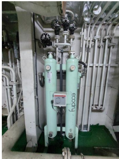
Ilustración 179. Secador de aire. Elaboración propia.
