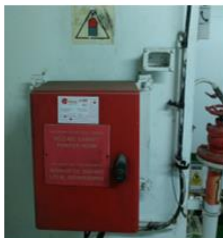
Ilustración 24. Disparo de CO 2 local de depuradoras. Elaboración propia.
