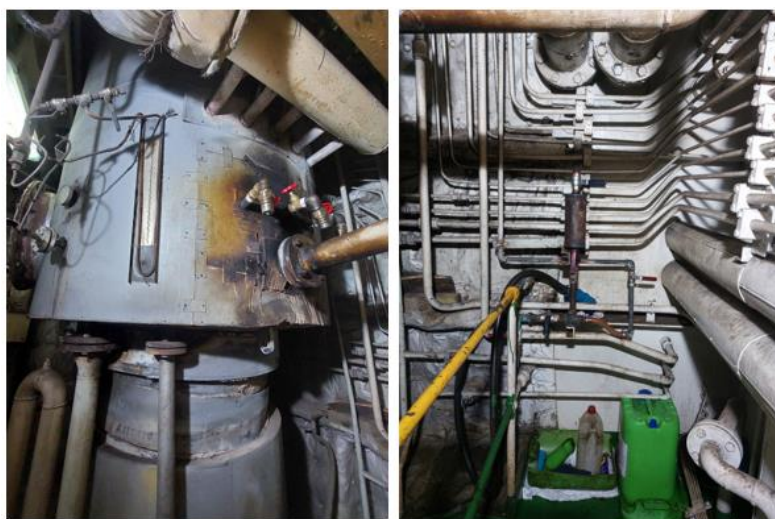
Ilustración 33. Lavado del economizador. Elaboración propia.
