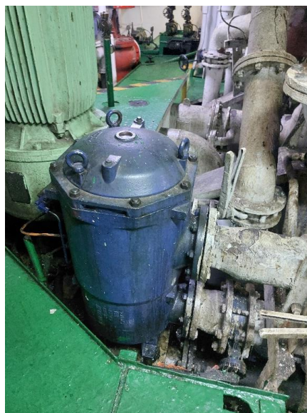
Ilustración 141. Filtro automático de aceite. Elaboración propia.
