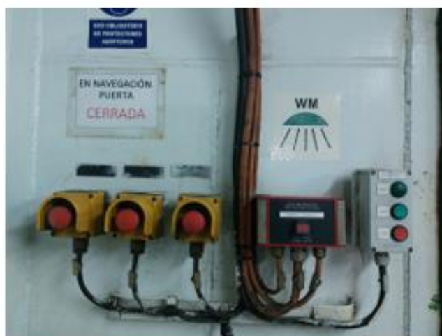
Ilustración 24. Disparo de CO 2 local de depuradoras. Elaboración propia.
