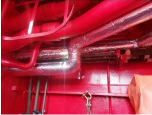
Ilustración 99. Línea de aceite térmico con calorifugado. Elaboración propia.
