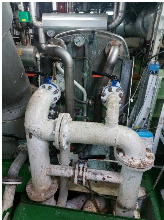
Ilustración 158. Evaporador. Elaboración propia.
