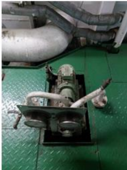
Ilustración 161. Bomba de llenado del sistema. Elaboración propia.
