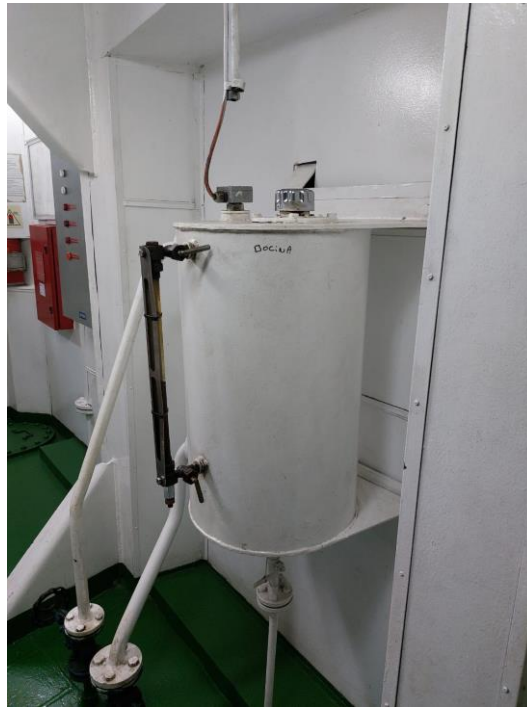
Ilustración 65. Tanque de compensación aceite bocina. Elaboración propia.
