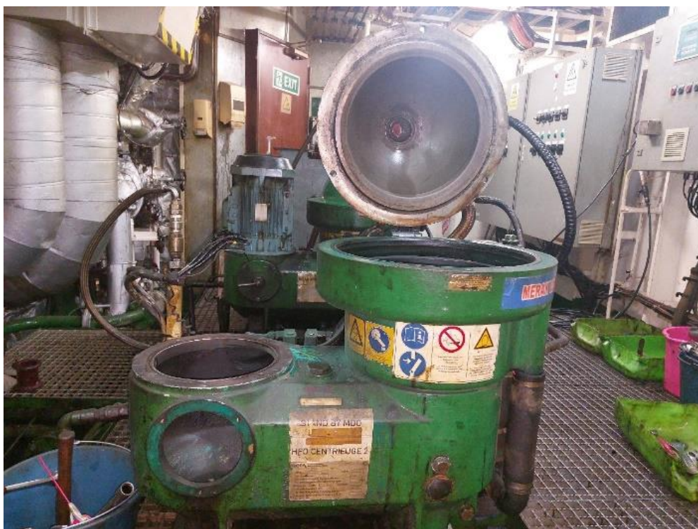
Ilustración 212. Depuradora desmontada. Elaboración propia.
