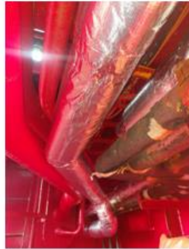
Ilustración 99. Línea de aceite térmico con calorifugado. Elaboración propia.
