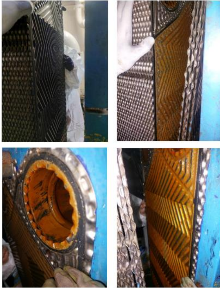
Ilustración 199. Limpieza de placas del enfriador de alta temperatura. Elaboración propia.
