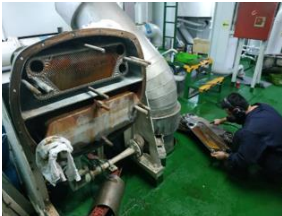
Ilustración 197. Limpieza de placas del evaporador. Elaboración propia.
