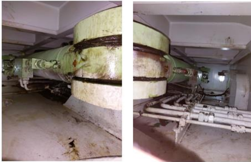
Ilustración 55. Servomotor, visto desde ambos lados. Elaboración propia.
