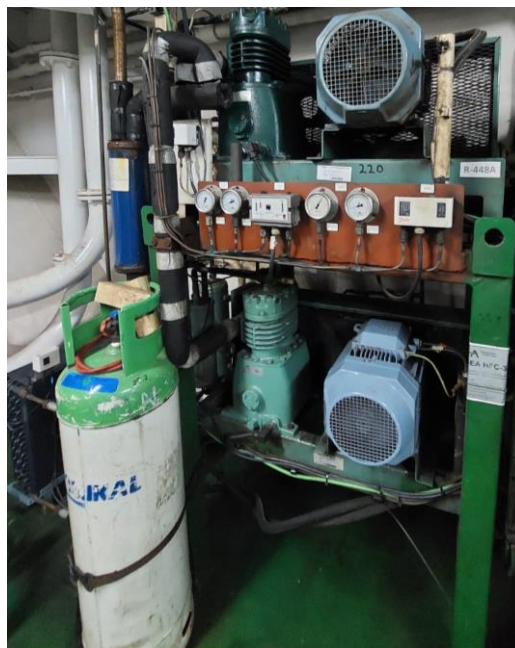
Ilustración 60. Compresores gambuzas. Elaboración propia.
