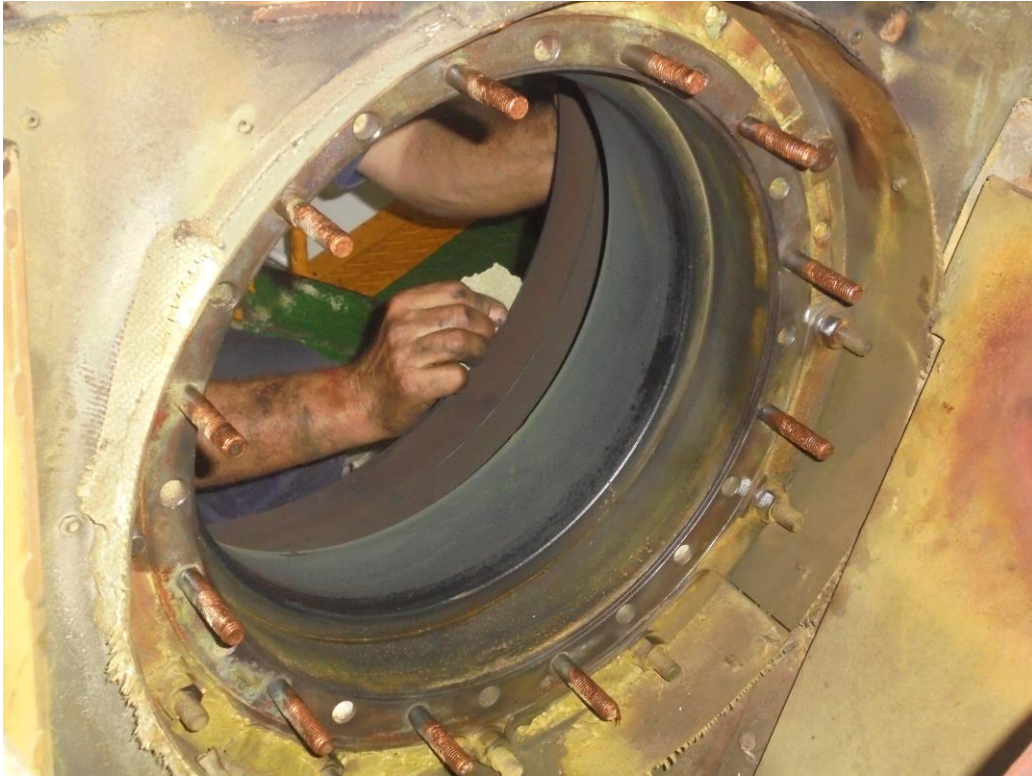
Ilustración 188. Turbocompresor desmontado. Elaboración propia.
