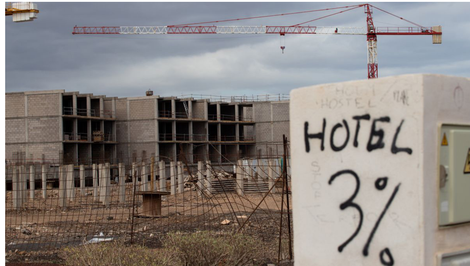
Obras en la playa de La Tejita, Granadilla de Abona
