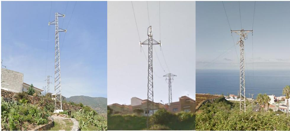
**Figura 11.** Torres de distribución en distintas ubicaciones de Tenerife con las configuraciones de circuitos simples, de izquierda a derecha, configuración en bandera, delta y horizontal.
