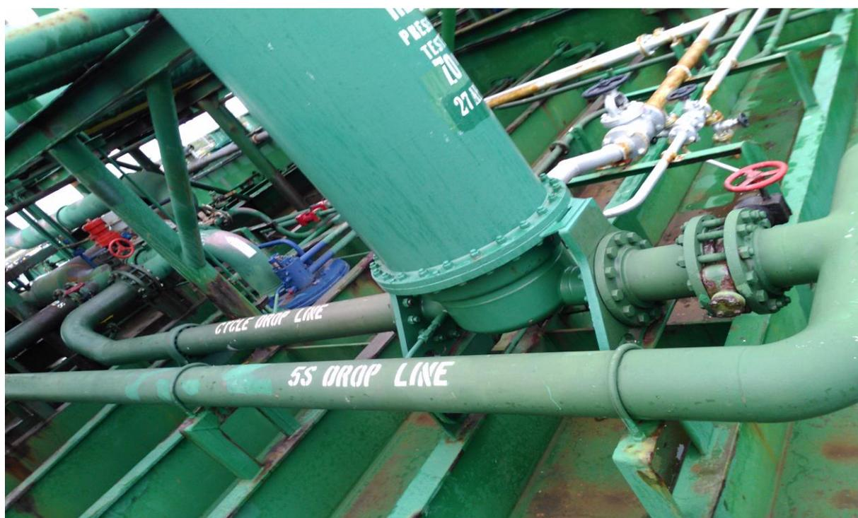
Ilustración 36: Línea de bajada -drop line-. Fuente: Trabajo de campo
