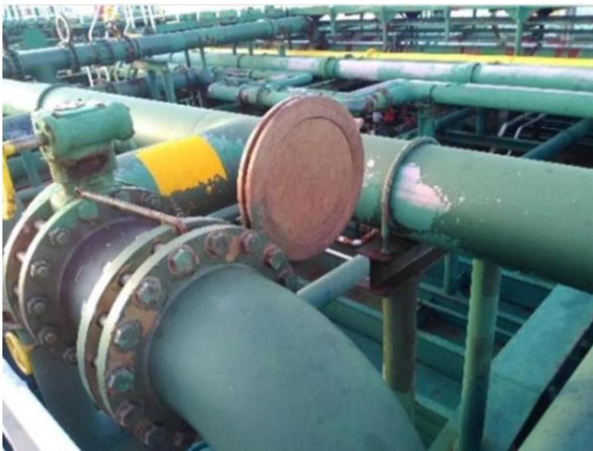
*Ilustración 18: Válvula de segregación. Fuente: Trabajo de campo*
