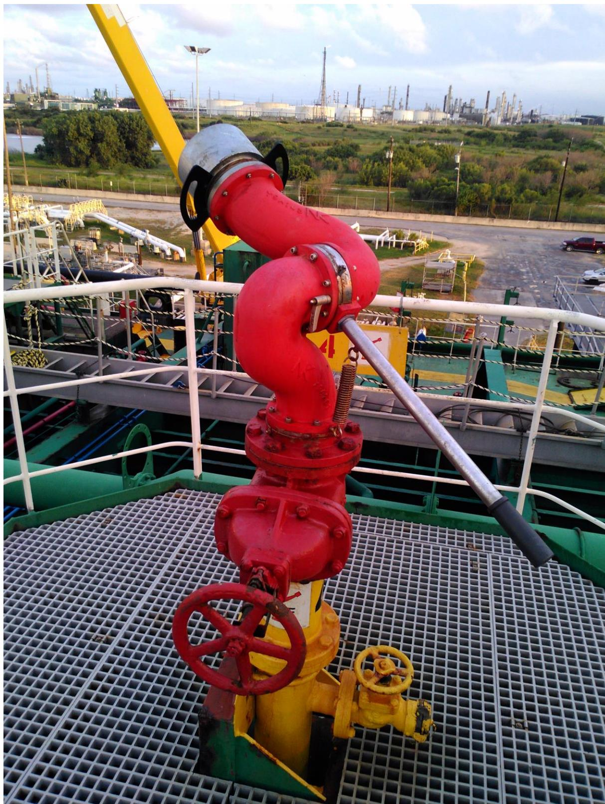
Ilustración 50: Cañón de espumógeno fijo cubierta. Fuente: Trabajo de campo.
