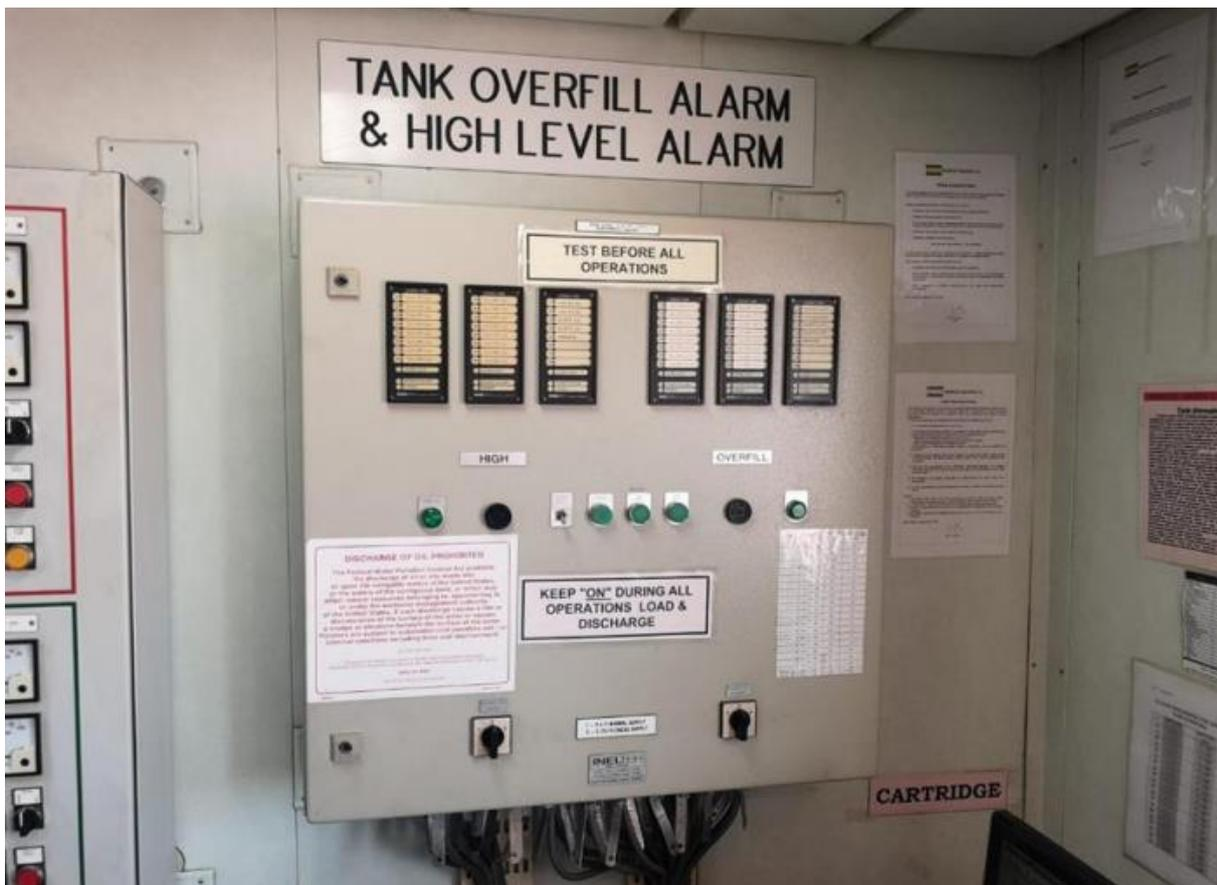
Ilustración 11: Panel de High Level y Overfill. Fuente: Trabajo de campo
