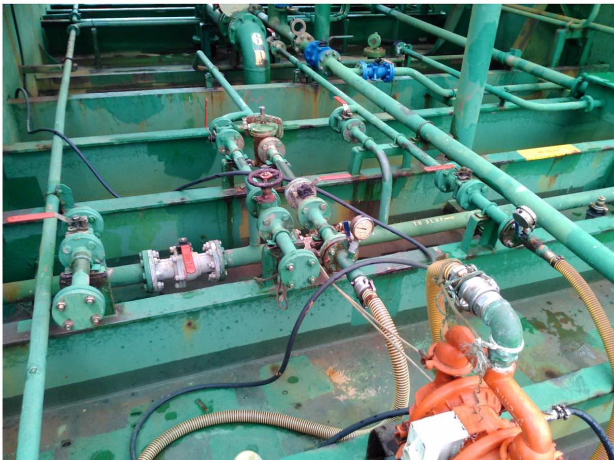
Ilustración 14: Transferencia de carga remanente al Slop. Fuente: Trabajo de campo.
