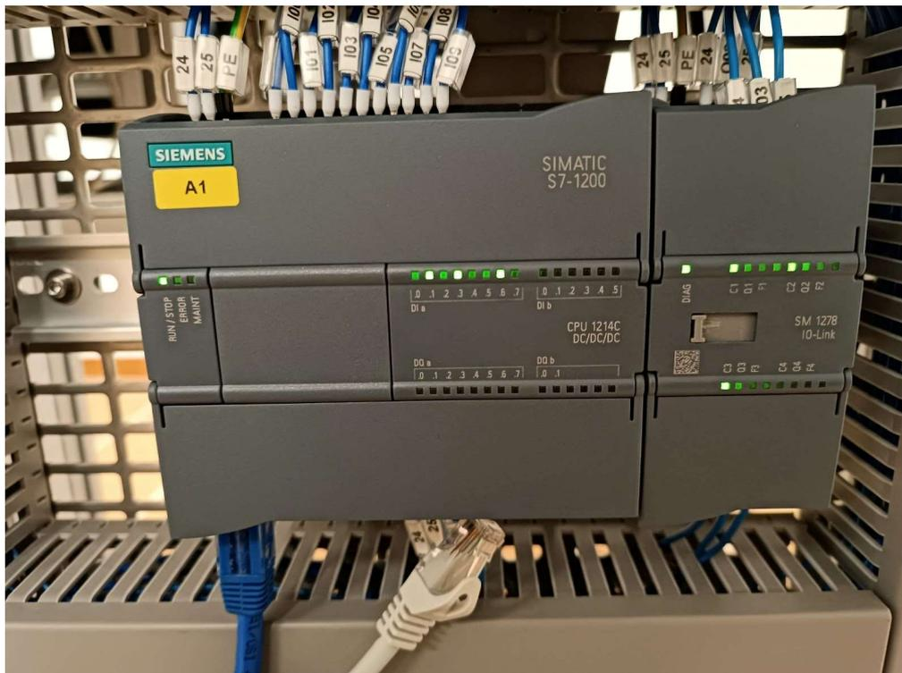
Figura 67: Autómata S7-1200 y Módulo IO-Link de la estación FAS-209.
