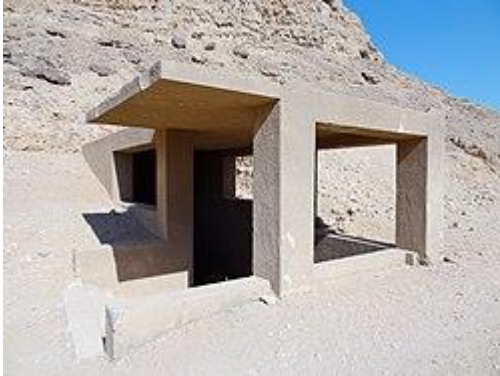
Fig.25, Entrada a la Tumba Real de Akhenatón y Mekeatón, que muestra una protección moderna contra inundaciones.
