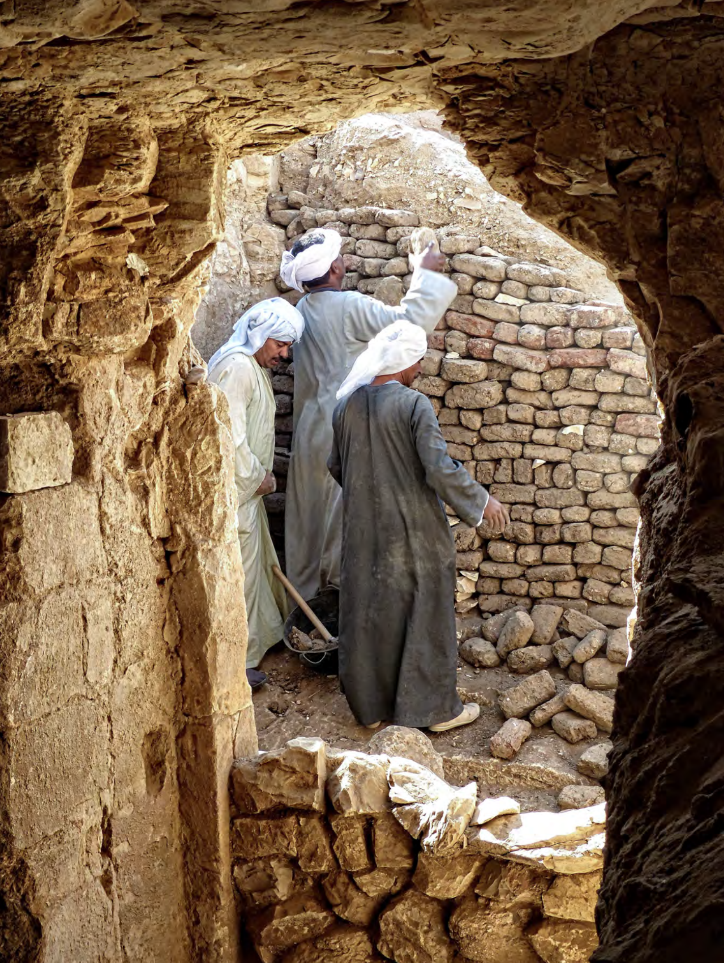
Fotografía 48. Protección de los perfiles estratigráficos en el patio al término de la segunda campaña.
