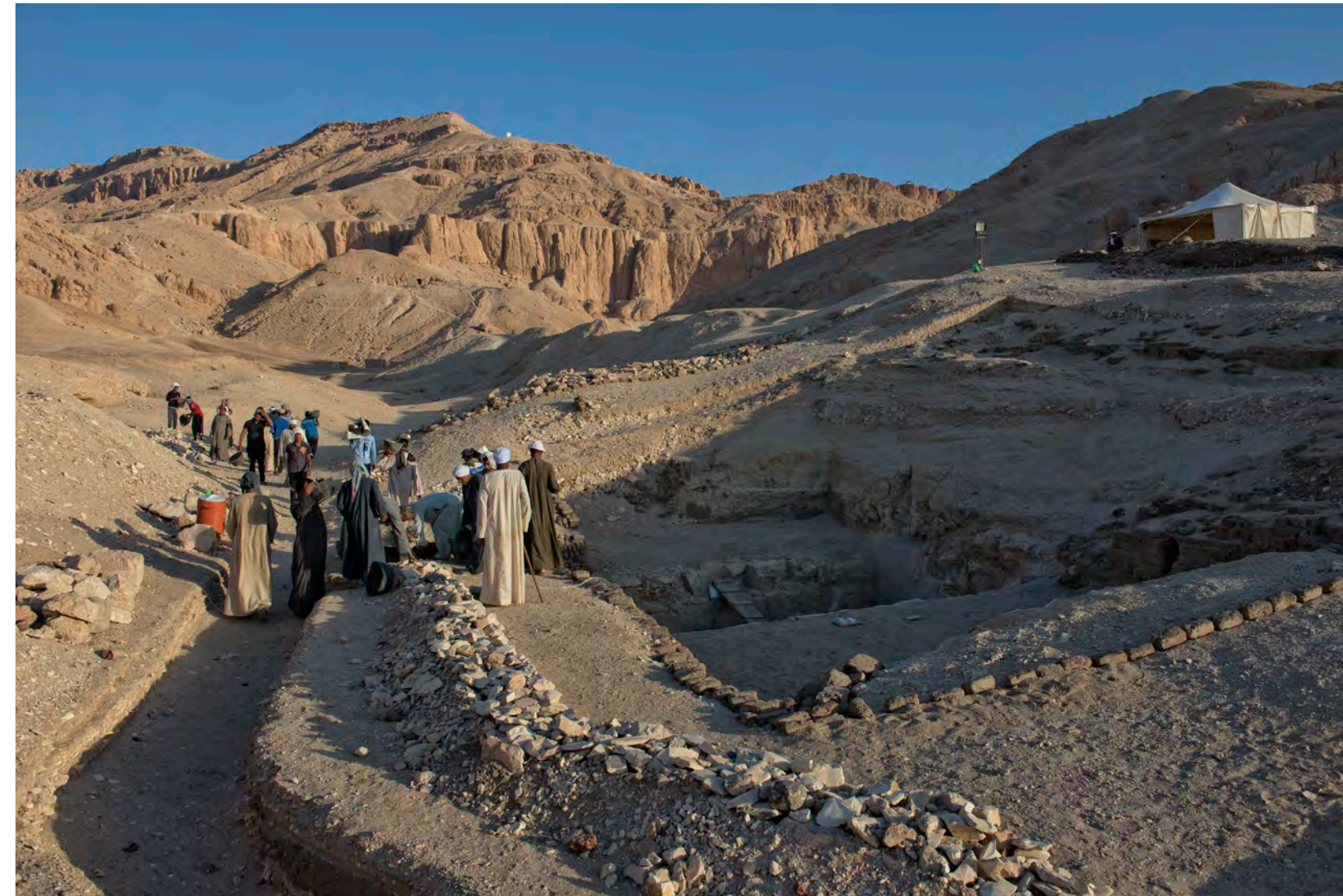
Fotografía 17. Protección frente a posibles riadas mediante un canal de evacuación en el wadi.
