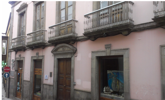
Exterior del centro Azafatas de Canarias
