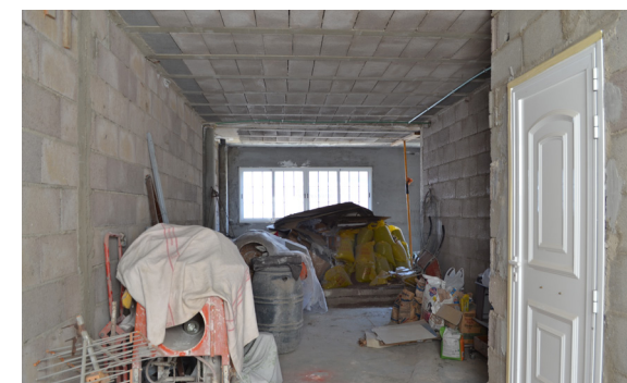
Interiores del centro.
