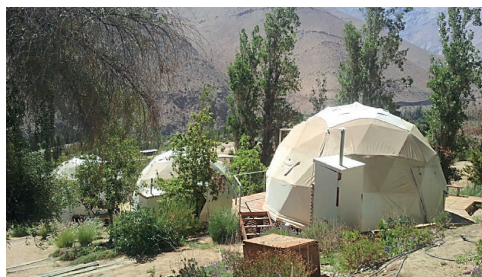
3. Hotel Elqui Doms (Municipalidad de Paihuano). Primer hotel temático. Alojamiento en forma de cúpula con posibilidad de observación del cielo a través de aperturas. Emprendimiento privado.
