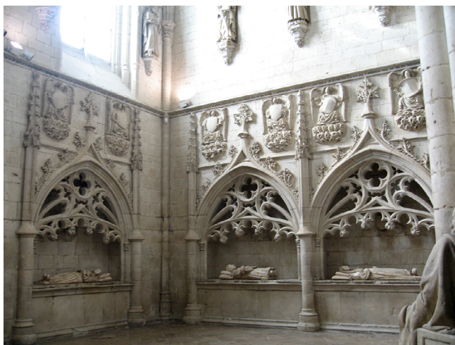
Lám. 9. Capilla del contador Saldaña, en Santa Clara de Tordesillas (fotografía Fernando Villaseñor).
